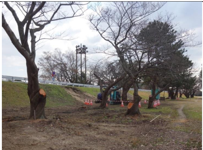
JR下流左岸堤防法面の倒木跡の損壊状況
