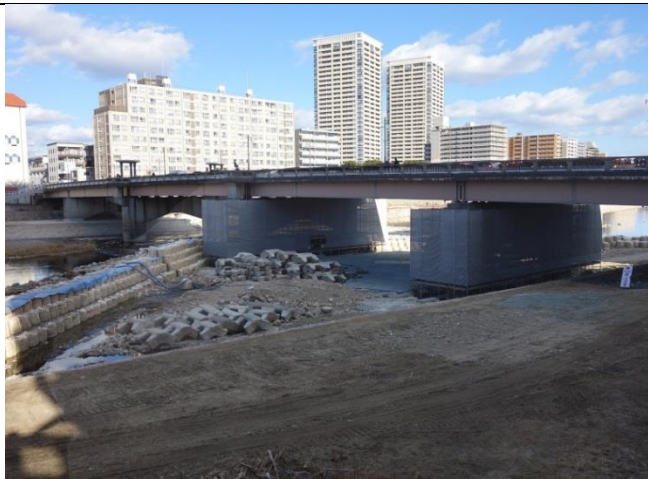
宝塚大橋橋梁補修工事
