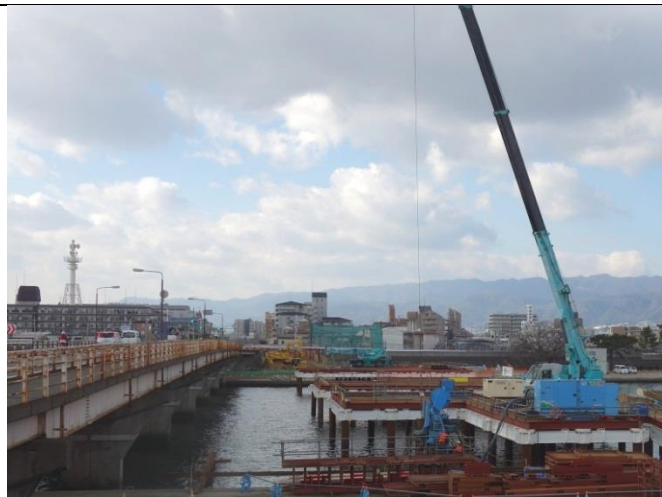
南部橋架け替え工事
