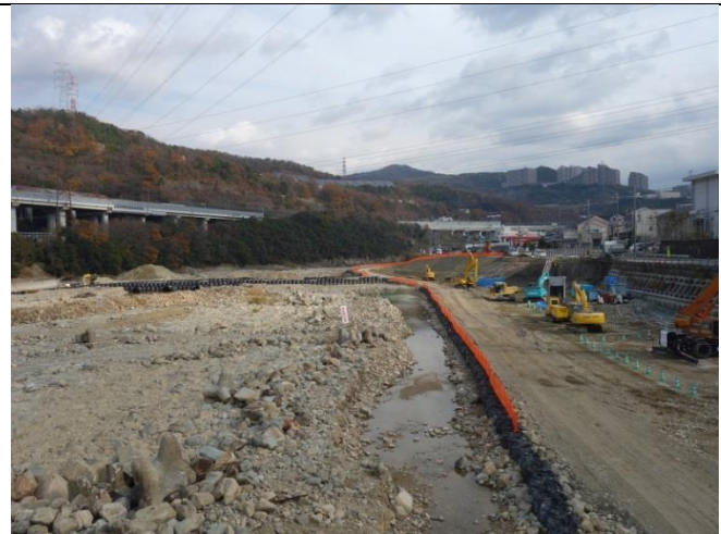
西宝橋下流側の瀬変え工事の様子
