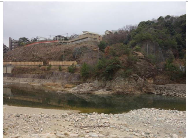
見返り岩付近の擁壁工事で斜面の緑が失われた。
