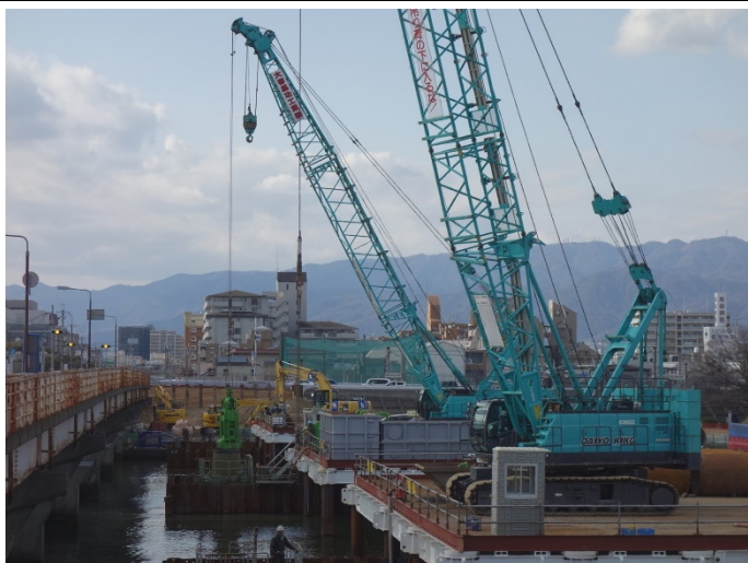
南部橋の杭打ちが始まった
