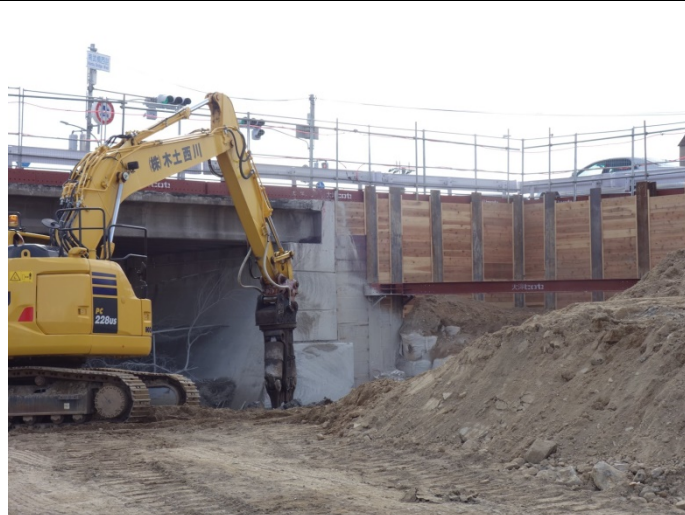
南部橋右岸基部の工事現場
