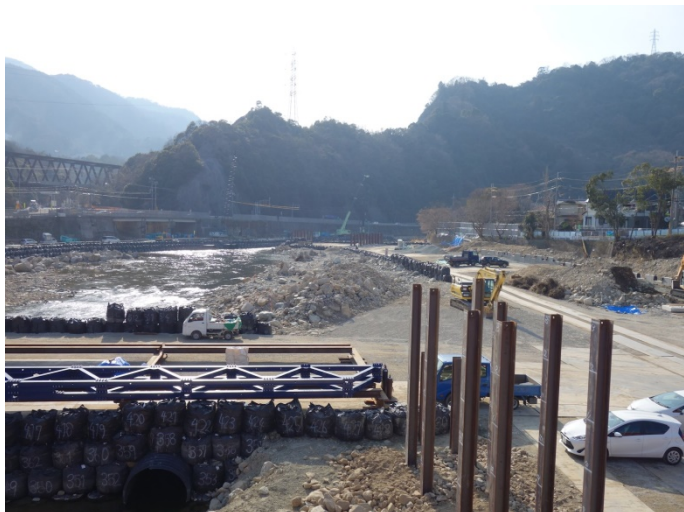
西宝橋仮設工事始まる
