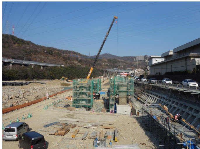
国道 171 号線付け替え工事？（西宝橋右岸下流方向）
