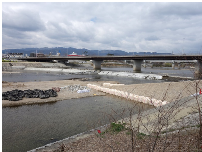
4号堰復旧工事始まる
