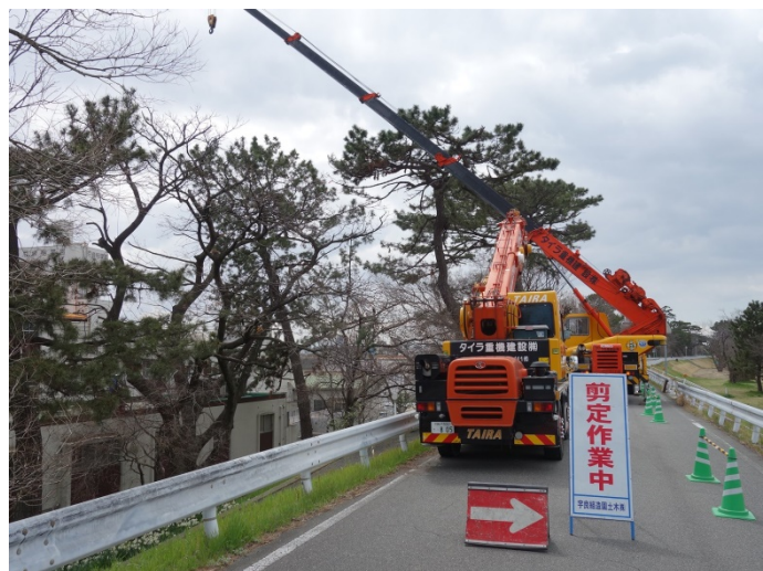
武庫川稲葉荘堤外エノキ剪定作業
