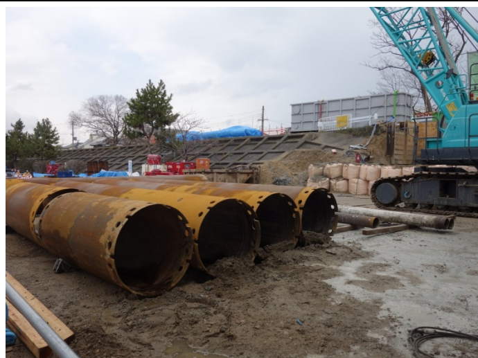
ケーシング(管を打ち込み、土砂をハンマクラブ掘削後セメント注入)
