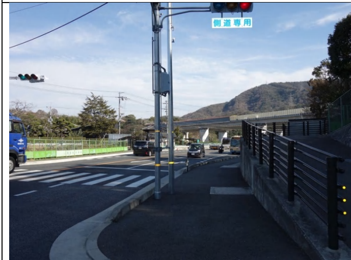
新しい国行為道は木之元付近から福知山線廃線敷を通る
