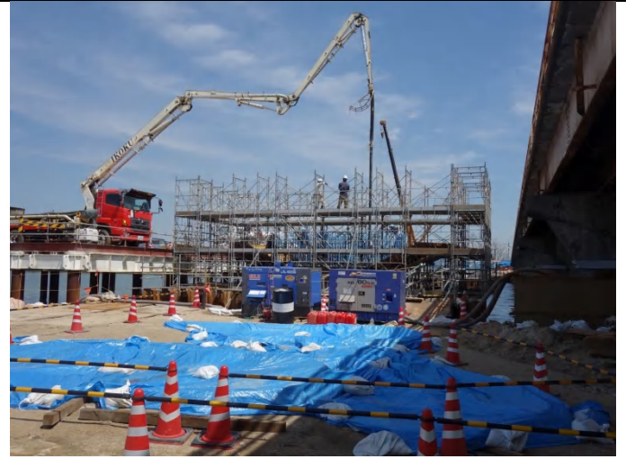
橋脚上部鉄筋組み立て工事始まる
