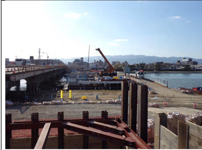
両岸の橋梁基部下部構造物工事始まる
