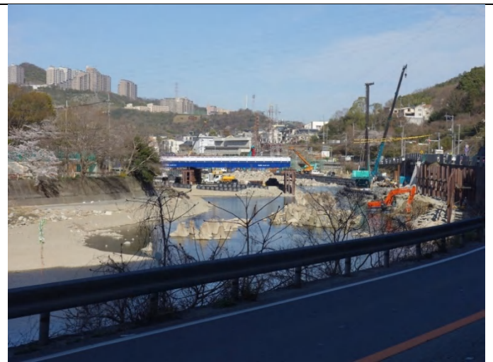
大きく景観が変わりそうな西宝橋付近の現状
