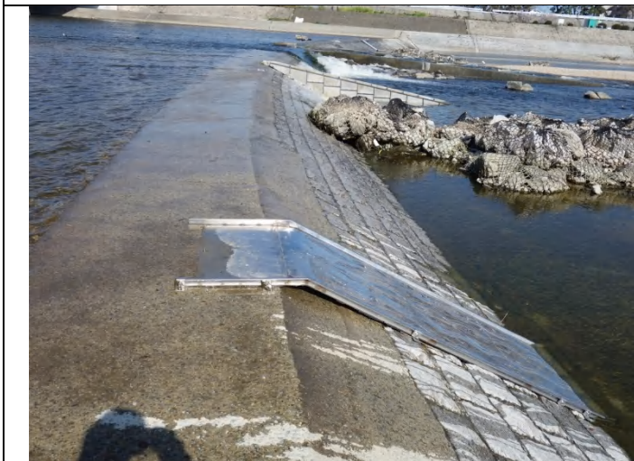
2号堰鋼製魚道設置された 滑り台状のものが追加された
