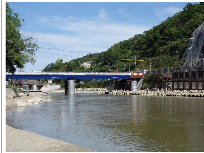
左岸から見た車両用仮設西宝橋
