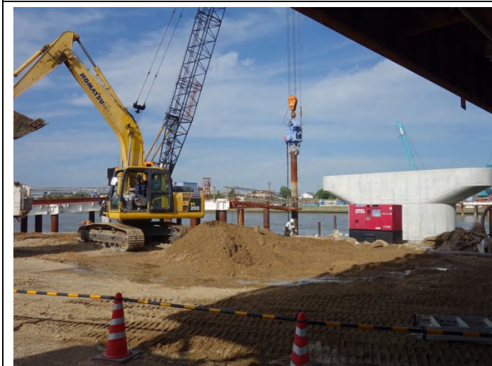
作業台撤去が進む右岸側南部橋架け替え工事現場
