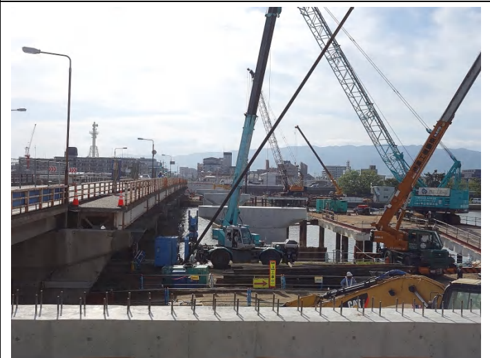
左岸から見た南部橋架け替え工事現場
