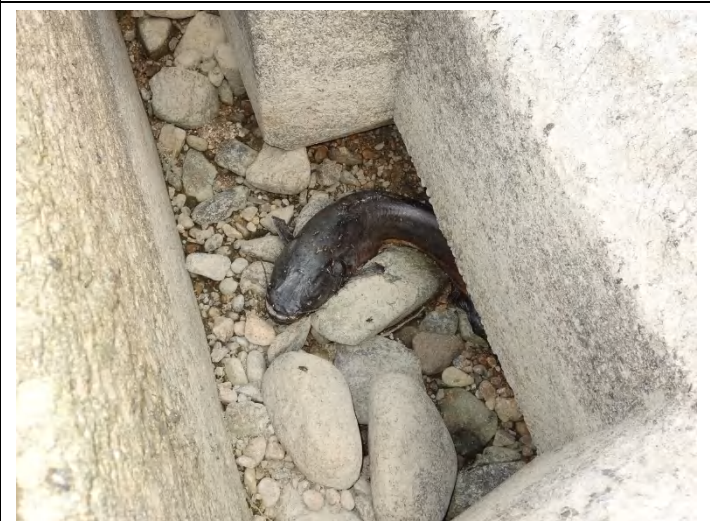
堰直下床止め工に取り残され干からびたナマズ
