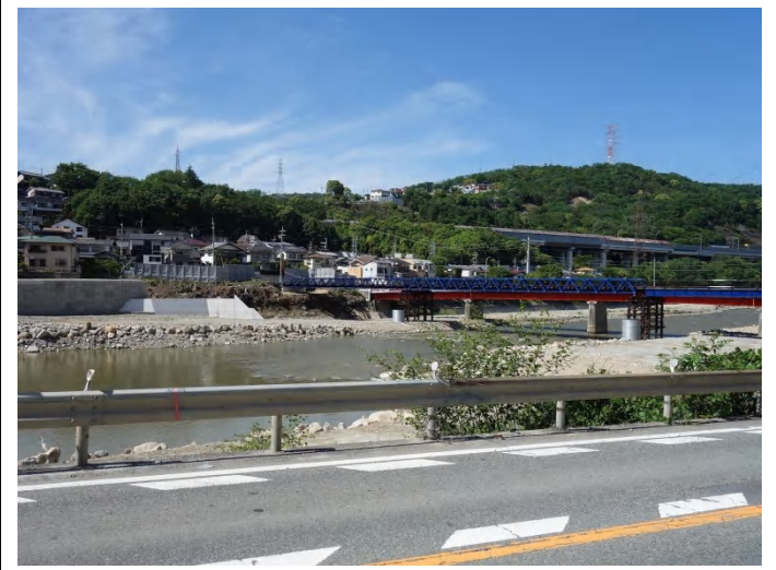
右岸から見た人道用仮設西宝橋と左岸仮設車道
