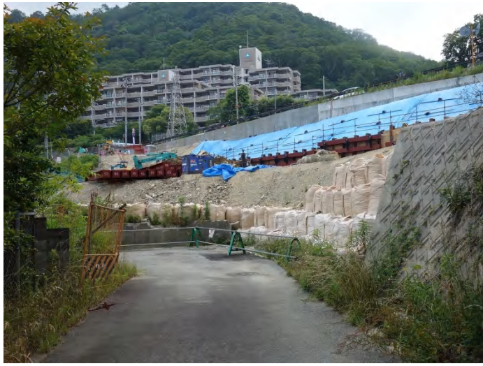
国道付け替え仮設道路工事が始まったリバーサイト住宅跡地
