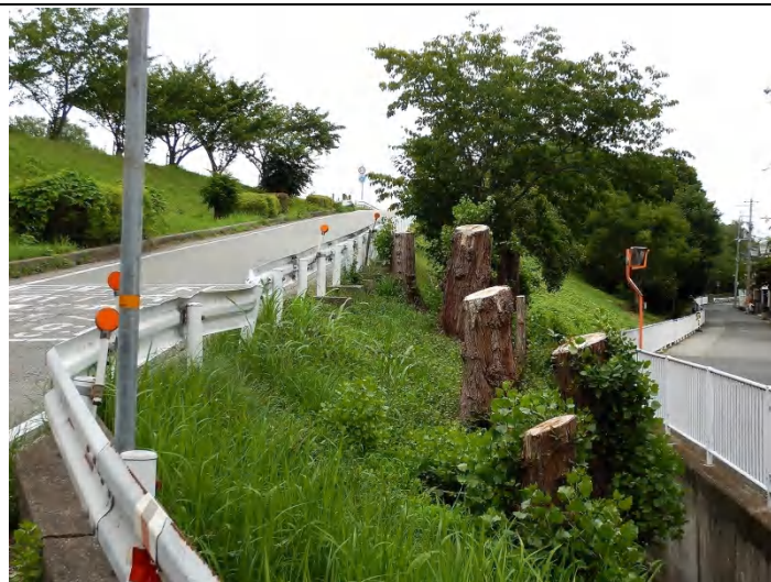
堤防・高水敷の伐木・剪定など樹木管理が進んでいる。
