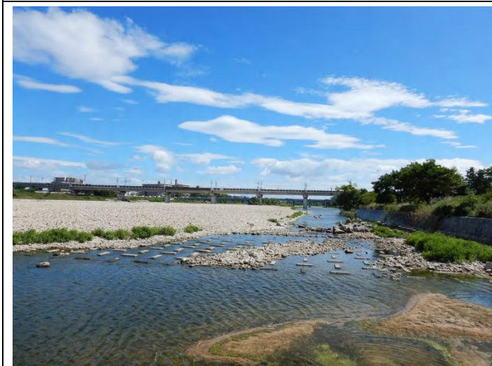
土砂堆積が進む（5堰下流方向）
