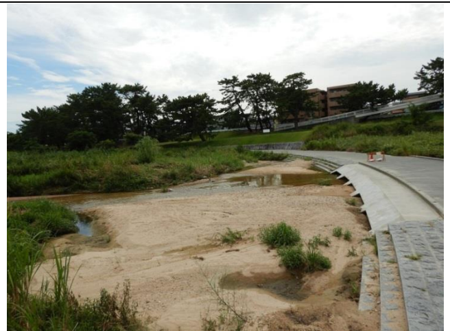
日を追って進む土砂堆積(8月22日仁川潜水橋)
