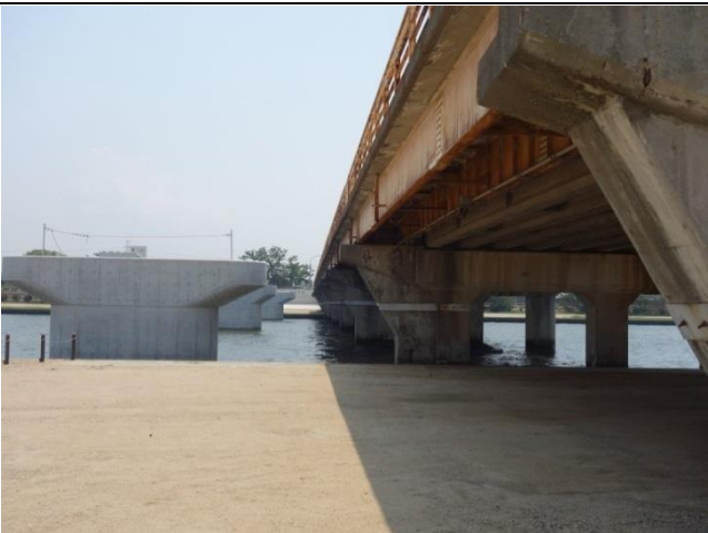
新旧入れ替えを待つ南部橋
