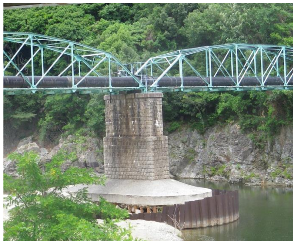
武庫川峡谷で老朽化が進む水管橋の橋脚部
