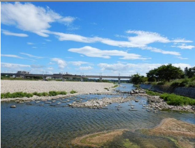
土砂堆積が進む(第5号床止工下流方向)
