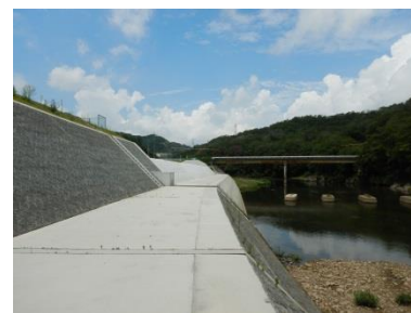
大岩橋右岸にある遊水池の越流堤
