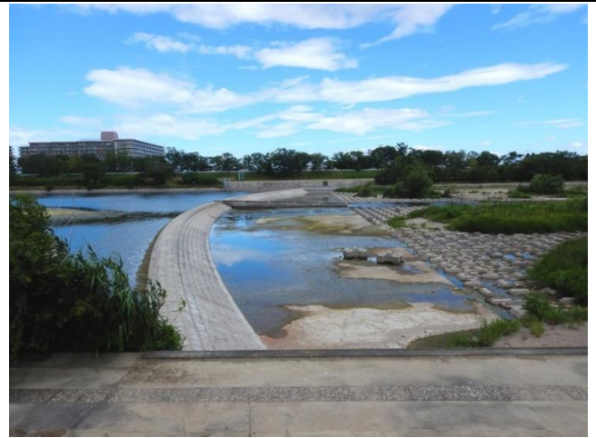
8月13日の第6号床止工(甲武橋)、僅かに魚道のみ流れる
