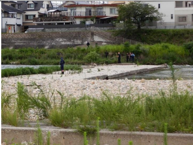
百間樋下流帯工で実施されていた川幅を計測するような作業
