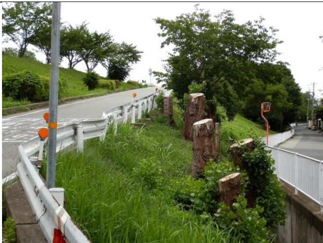
堤防・高水敷の伐木・剪定など樹木管理が進む
