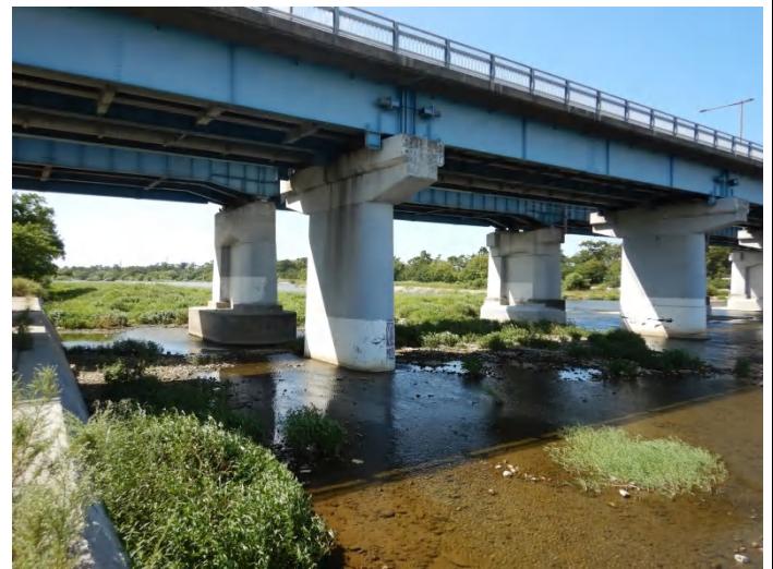
浚渫後約半年で砂州が育ち草原になった甲武橋下流砂州
