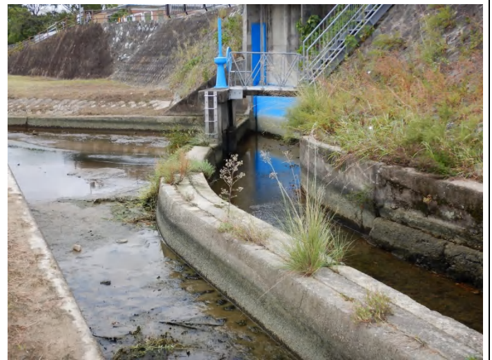
台風 19 号に備えて樋門閉鎖？
