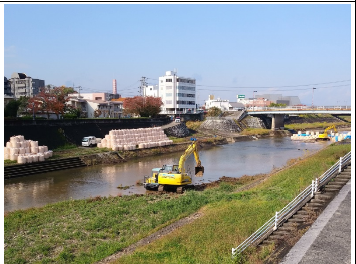
三田大橋下流改修工事始まる。(土谷氏提供)
