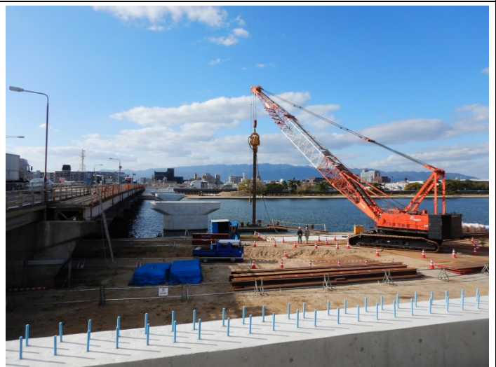
南部橋架け替え工事再開
