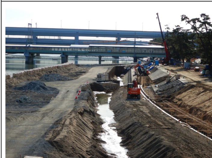
武庫川橋右岸下流拡幅矢板工事
