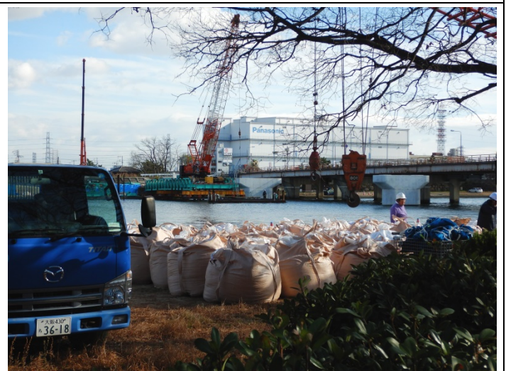
南部橋架け替え工事作業台づくり
