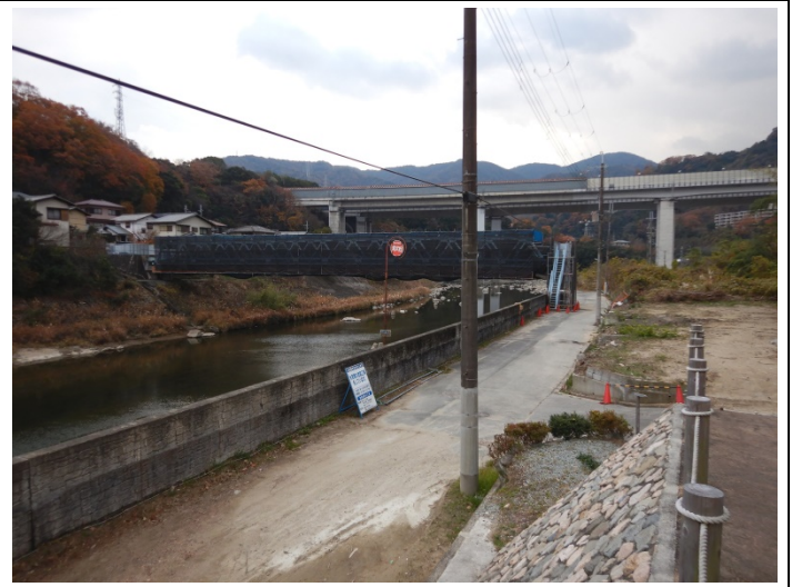
リバーサイト住宅跡地水管橋塗装工事に伴い通行止め
