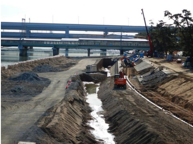
武庫川橋右岸下流拡幅矢板打設工事
