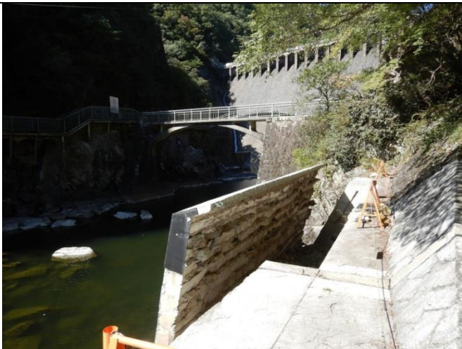
千苅ダム護岸崩壊 (10/9) 撮影、台風によるものではなさそう
