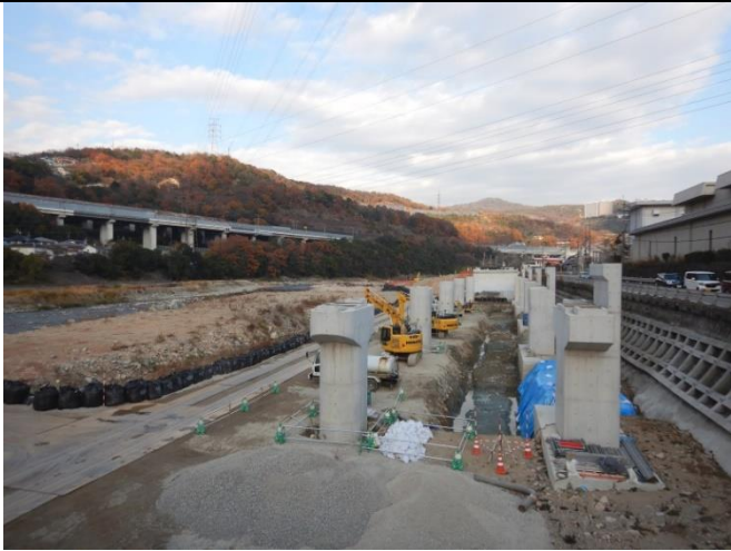
森興橋付近の工事は佳境に
