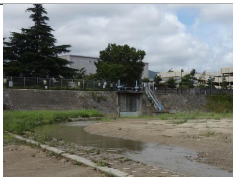
2018年台風21号で埋まった樋門水路
