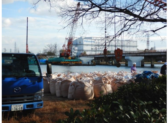
南部橋架け替え工事作業台づくり
