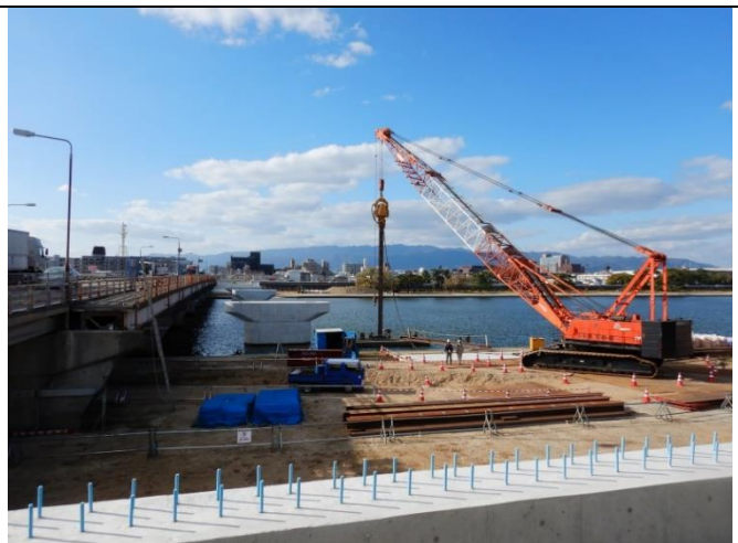
南部橋架け替え工事再開
