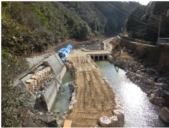
千苅ダム下流左岸護岸復旧工事
