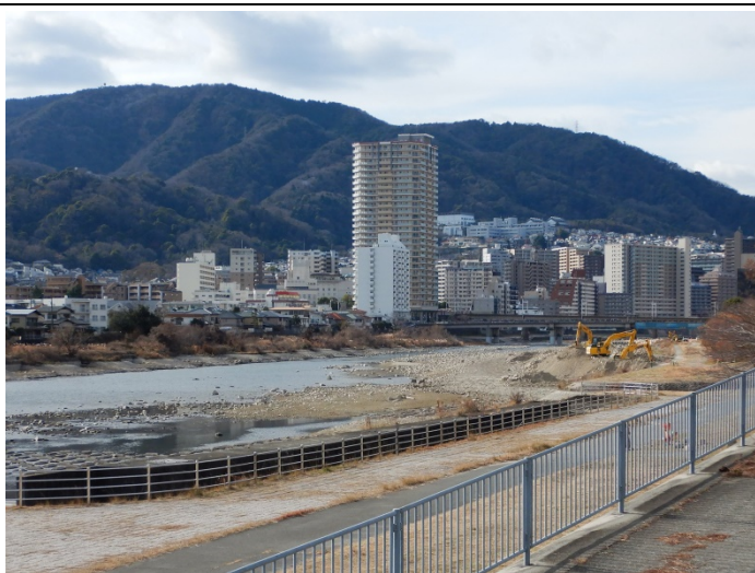
宝塚大橋改修工事で伊子志堰全転倒 (1月18日)
