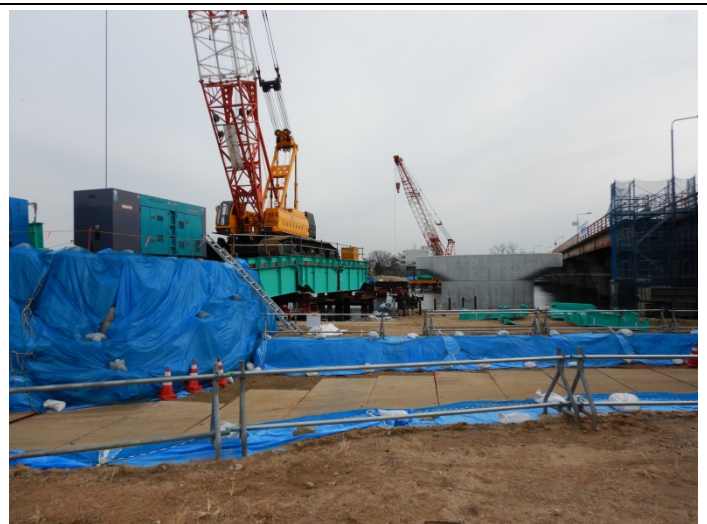
南部橋架け替え工事作業用橋梁づくりが続いている。
