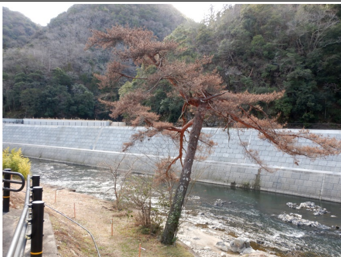
武田尾温泉地区改修工事終わって松枯れた
