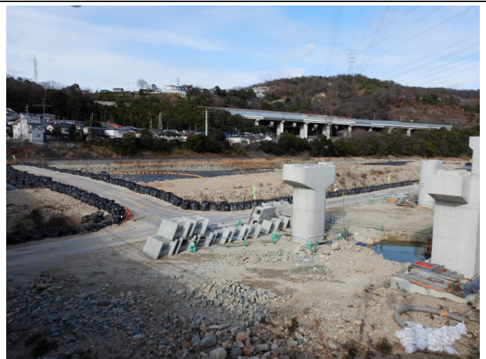
青葉台地区河川改修と名塩道路工事続く
