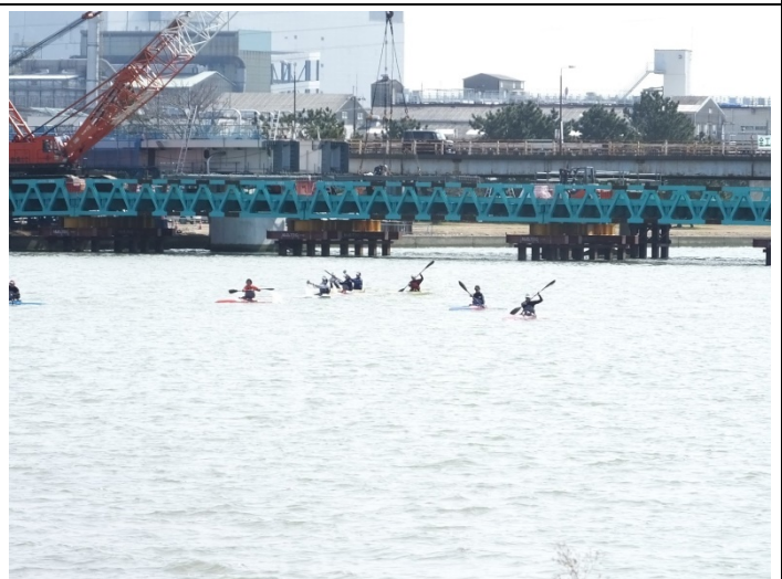
水温みカヌーが浮かぶ南部橋工事現場
