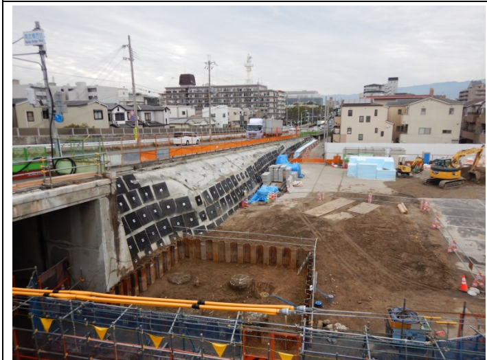
南部橋右岸取り付け道路基礎工事は始まる
