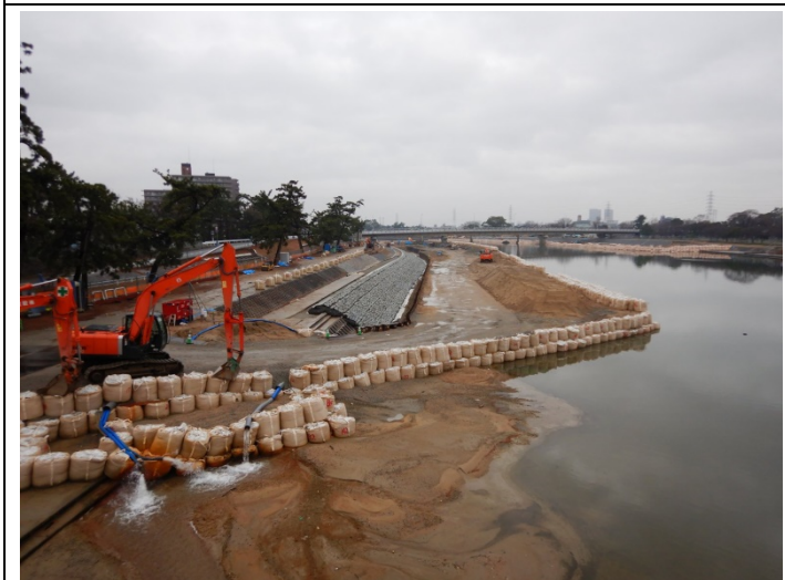
阪神武庫川駅からみた工事現場
