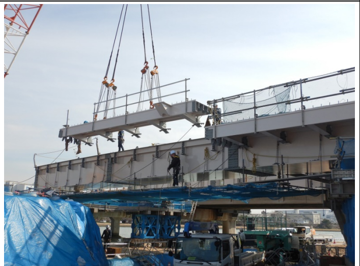
南部橋架橋工事は始まる
