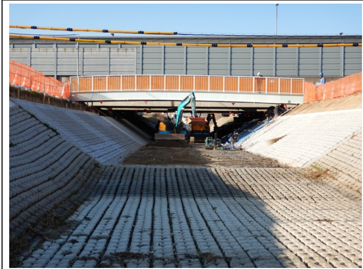
支川の改修工事も進む (天神川中国道下)
