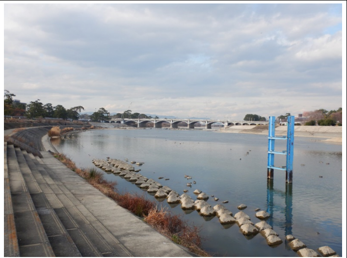
武庫大橋下流砂州がなくなる。アユ遡上してくれるかな？
