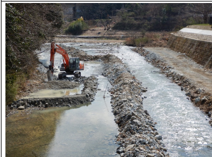
羽束川合流点の河床掘削で大量の濁水発生も止む得ないの
