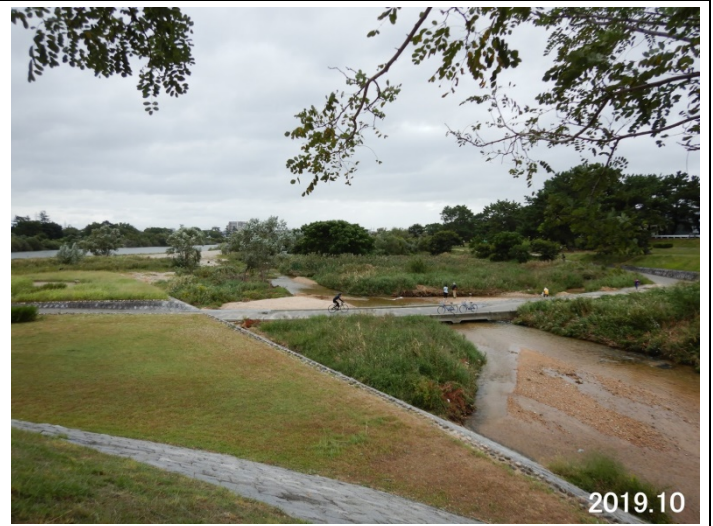
土砂掘削から約15年でここまで砂堆積と樹木繁茂した。
