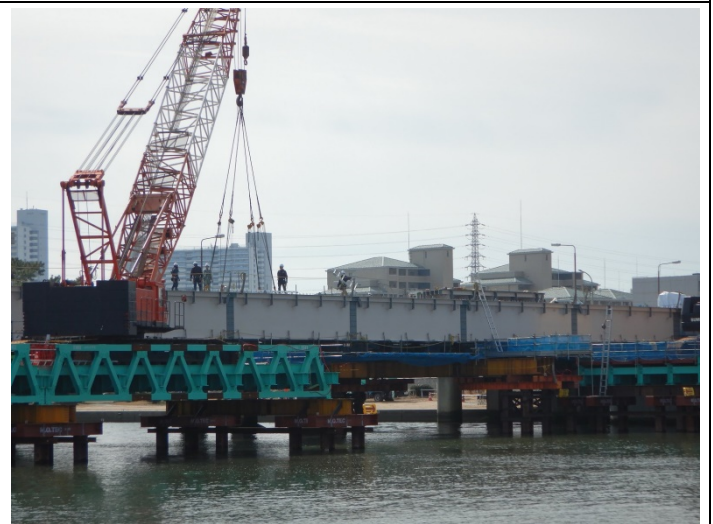
南部橋架橋工事 3月7日最後の橋桁架けられた
