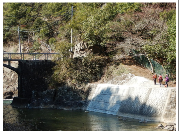
千苅ダム下流側護岸復旧、安全にハイキング楽しめる。
