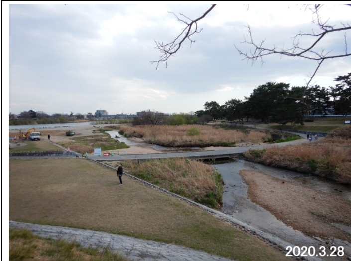
仁川合流点で除伐・除草工事が始まる。
