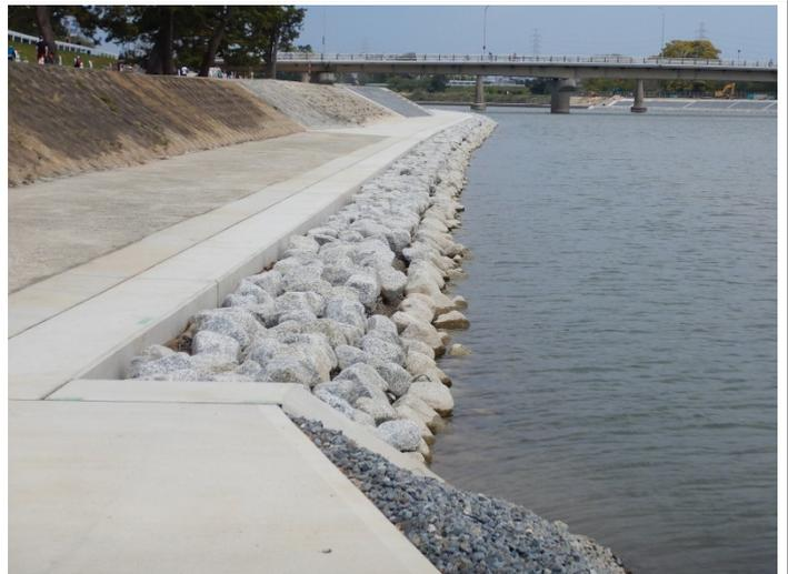
整備計画河床まで掘削 自然石金網張り護岸
