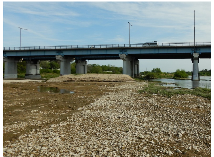
樋ノ口工区の土砂掘削（工事中断した模様）
