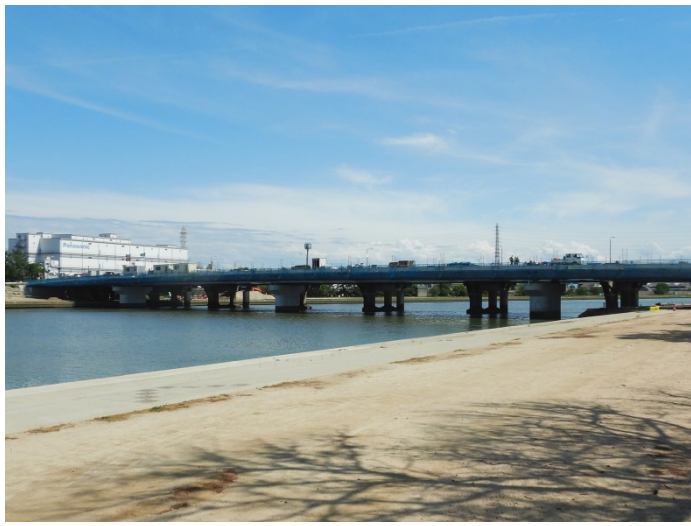
南武橋架橋工事終わり、艀装・舗装工事が続く
