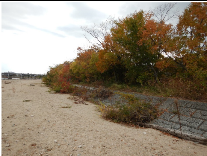
武庫大橋右岸上流（除伐前）
