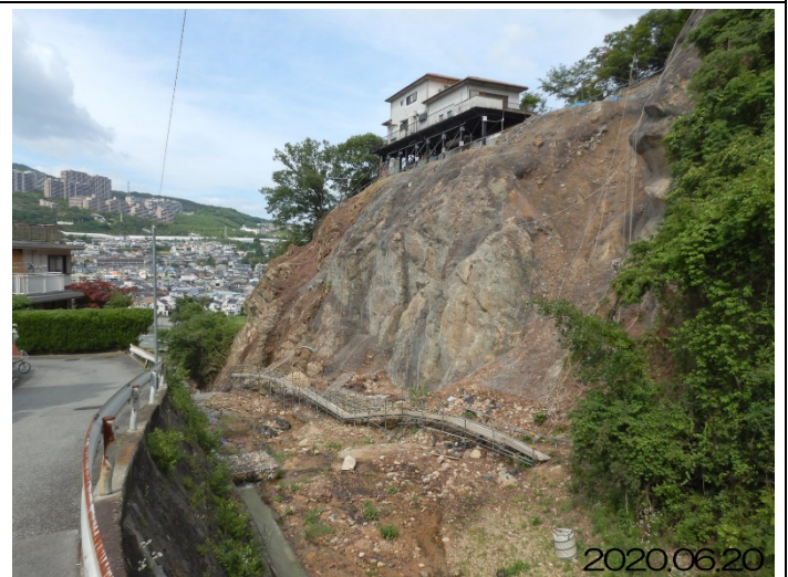
観音谷川崖保護工事。崖っ縁の民家崩落しそうな感じ。
