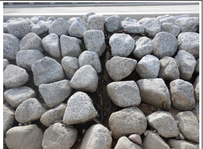
新しい護岸。テナガエビ石の隙間を住処にしてくれる？
