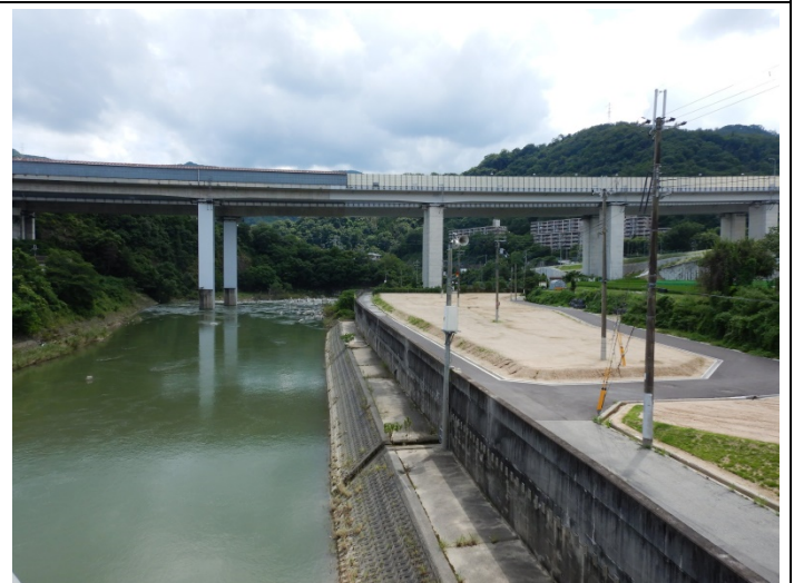
リバーサイト住宅跡地。水管橋に繋がる生活道路が唯一の進入路
