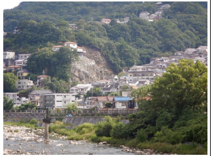
擁壁工事が進む観音谷川遠景
