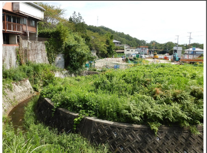
名塩川直線化工事始まる
