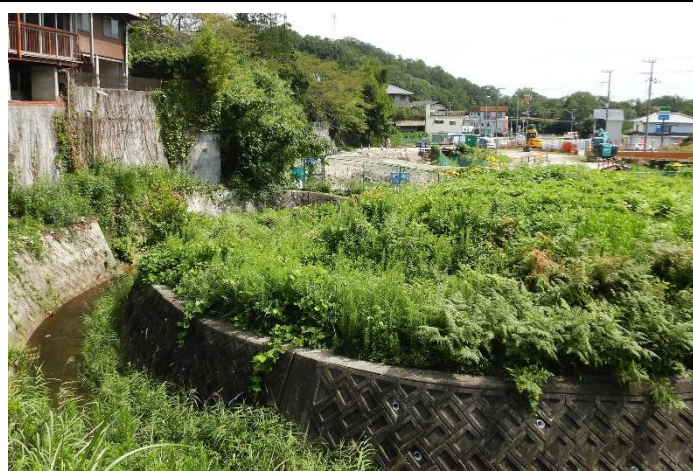
名塩川直線化工事始まる
