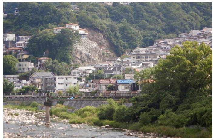
擁壁工事が進む観音谷川遠景
