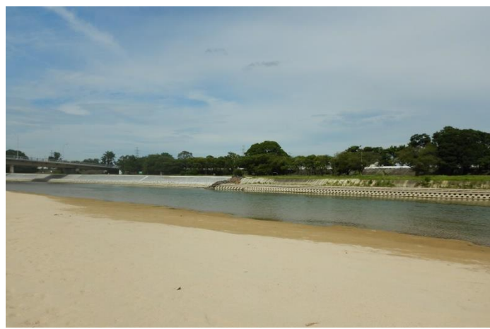
武庫川橋下流 (7月22日)
