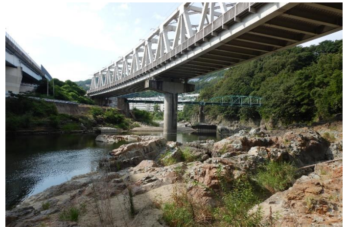
生瀬橋左岸下からみた峡谷景観
