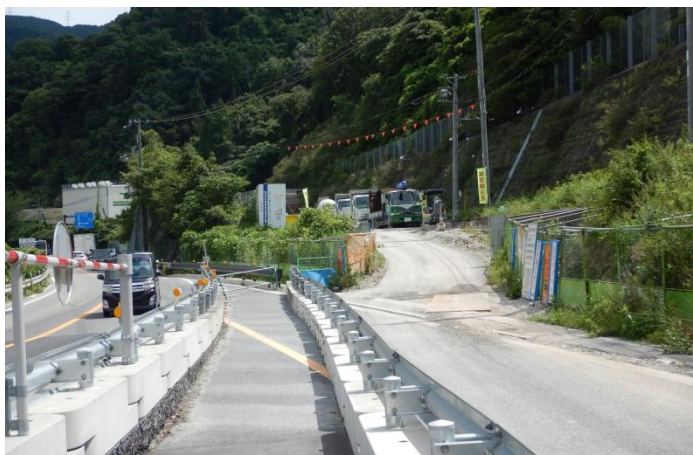
元リバーサイト住宅付近で城山トンネルへ分岐
