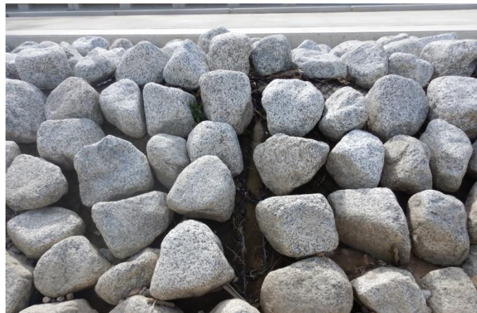
新しい護岸。テナガエビは石の隙間を住処にしてくれる？
