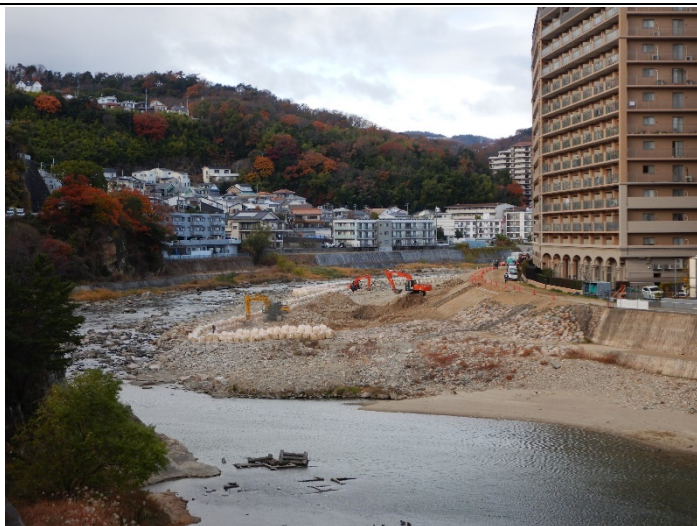
見返り岩対岸河床掘削
