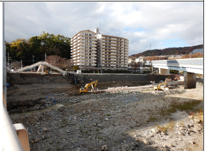
生瀬橋上流側河床掘削
