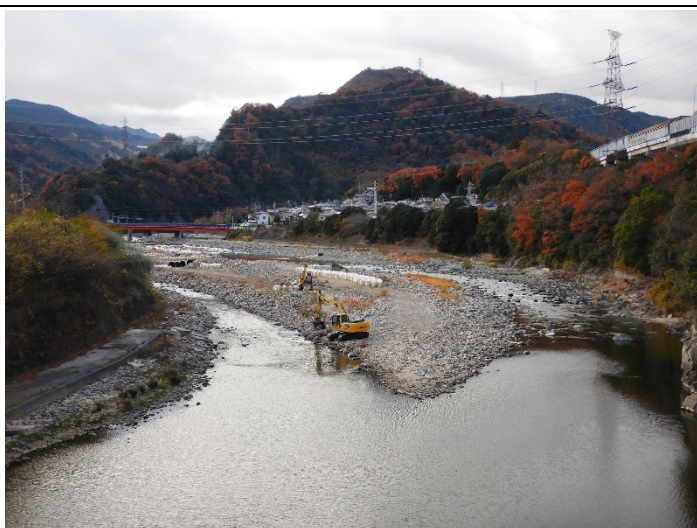
新興橋上流河床掘削
