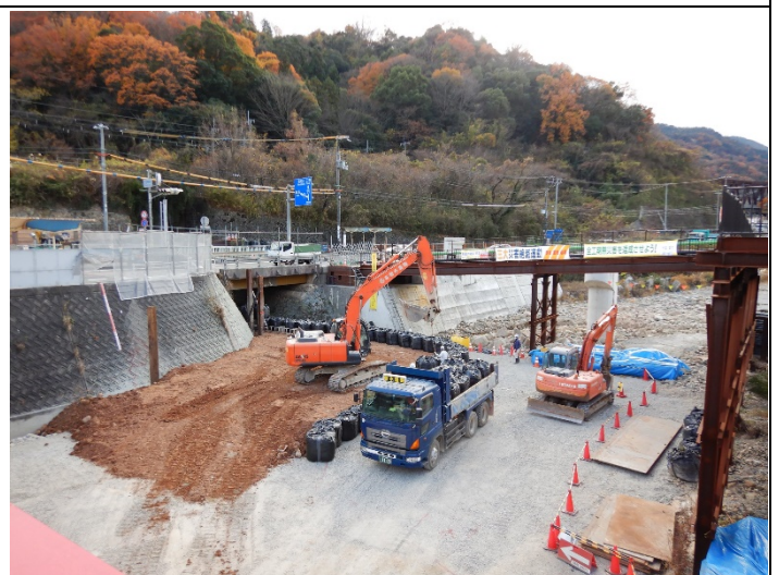
西宝橋仮設橋工事
