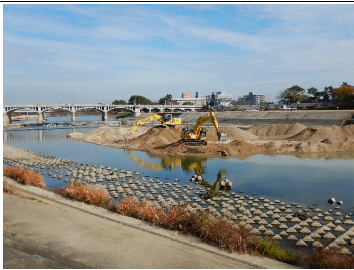
甲武橋下流河床掘削
