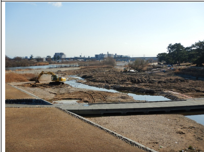
仁川合流点掘削工事始まる
