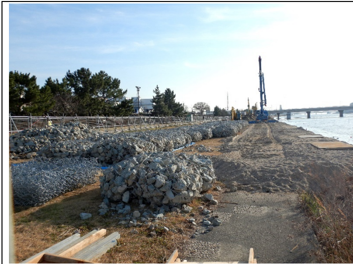
南部橋上流左岸根固め工事
