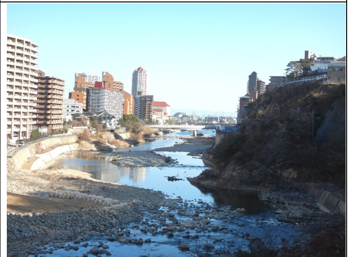
見返り岩対岸河床掘削工事
