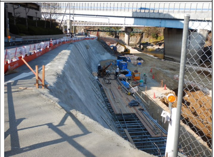
生瀬橋右岸 鉄筋挿入工事
