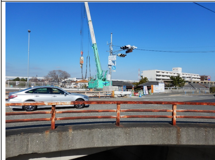
南部橋左岸道路との接続部で杭打ち始まる
