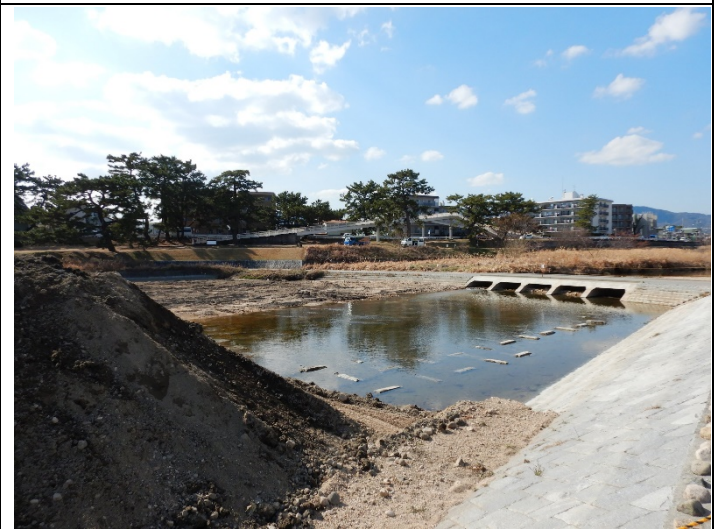
仁川合流部掘削工事、既設床止め工が現れた
