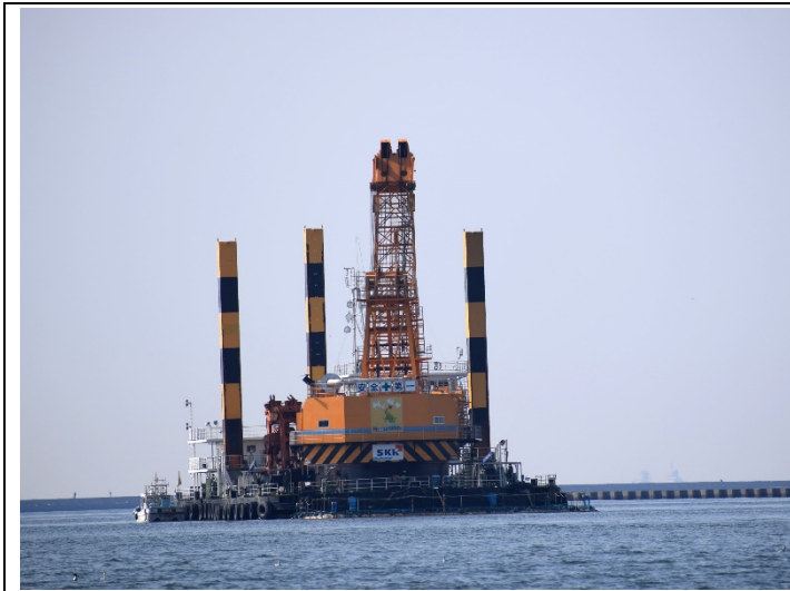
武庫川河口部で浚渫工事始まる
