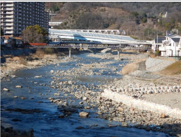
宝生ヶ丘付近から生瀬橋を望む
