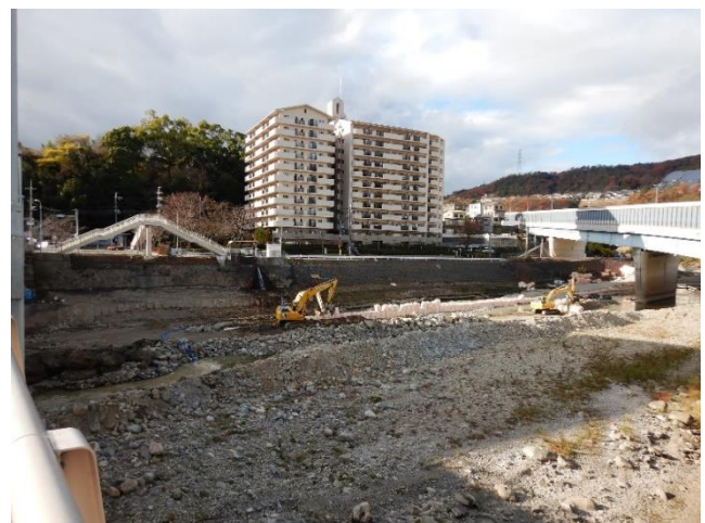
生瀬橋上流側河床掘削
