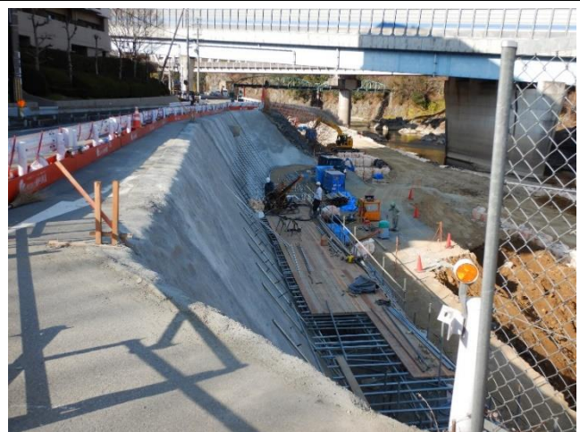
生瀬橋右岸 鉄筋挿入工事
