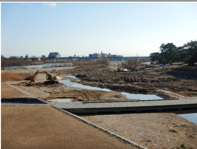
仁川合流点掘削工事始まる
