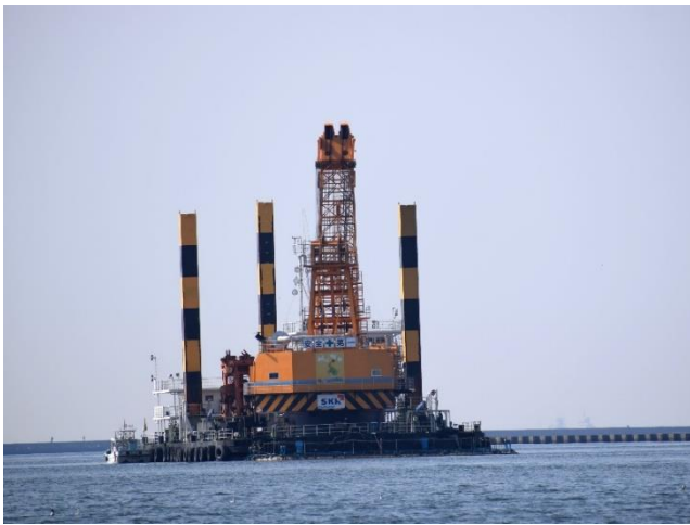
武庫川河口部で浚渫工事始まる
