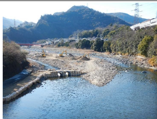
森興橋上流側の瀬替え工事。下流側も始まった。
