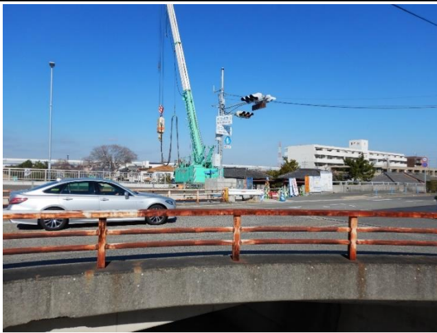
南武橋左岸道路との接続部で杭打ち始まる
