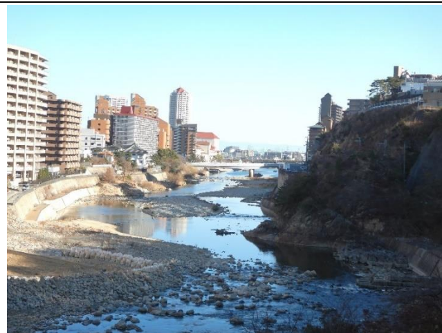
見返り岩対岸河床掘削工事
