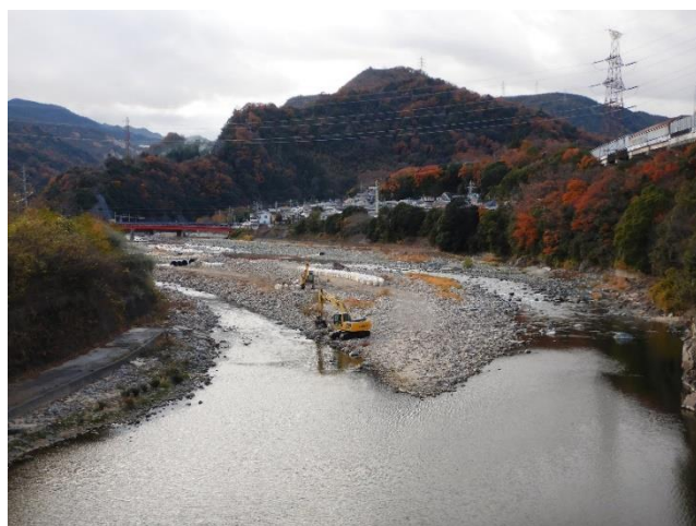
森興橋上流河床掘削
