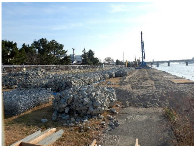
南武橋上流左岸根固め工事
