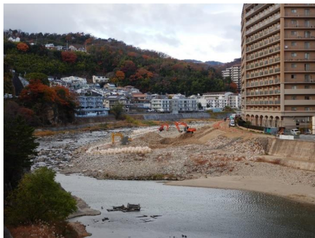
見返り岩対岸河床掘削
