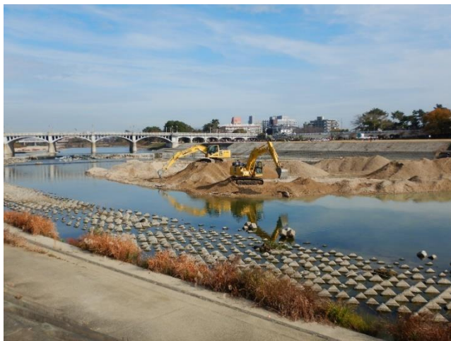
甲武橋下流河床掘削
