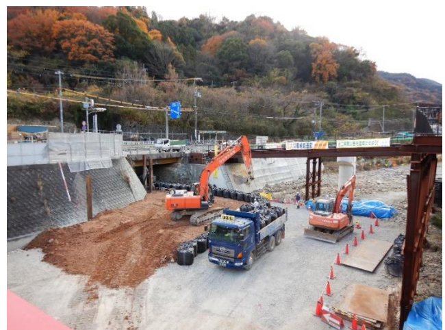
西宝橋仮設橋工事
