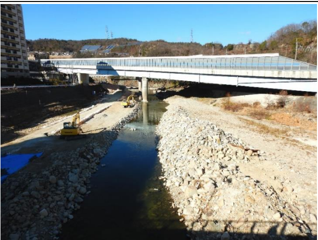
生瀬橋上流河床掘削と護岸改修工事
