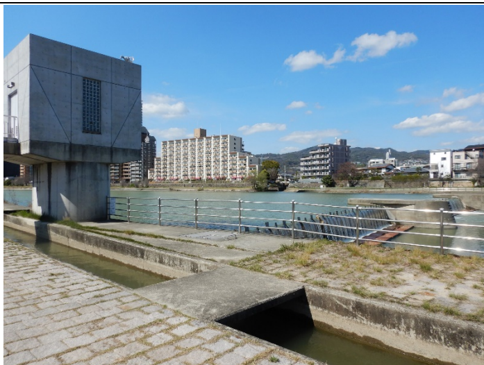
伊子志堰上流掘削工事終了して堰復旧した。
