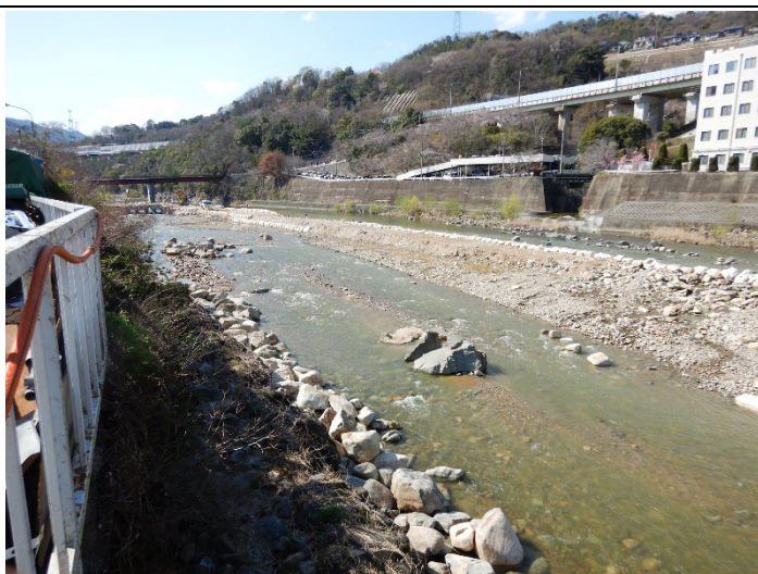
森興橋下流掘削工事で昔の岩が掘り起こされた感じ。
