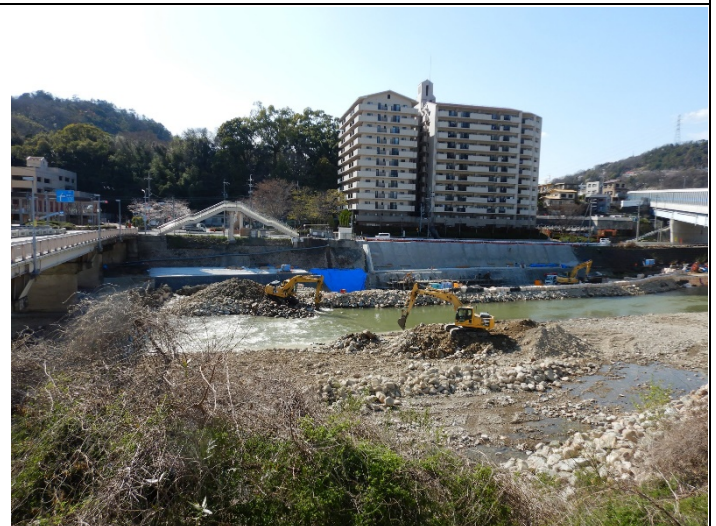
生瀬橋上流左岸の土砂撤去が進む。
