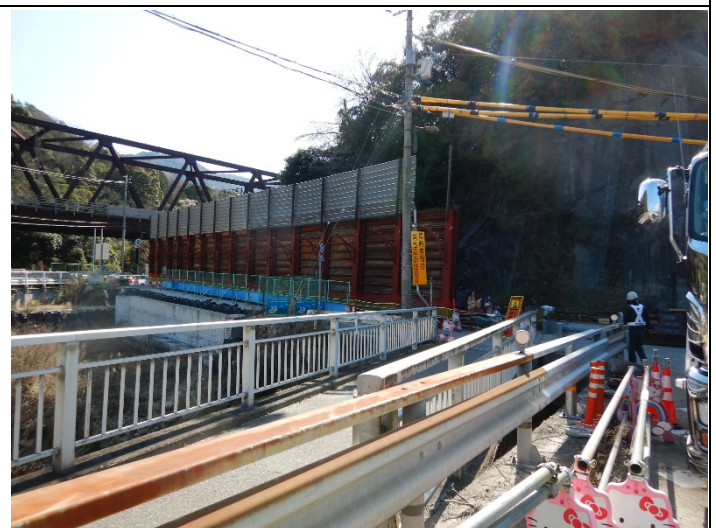
城山トンネル出口工事始まる
