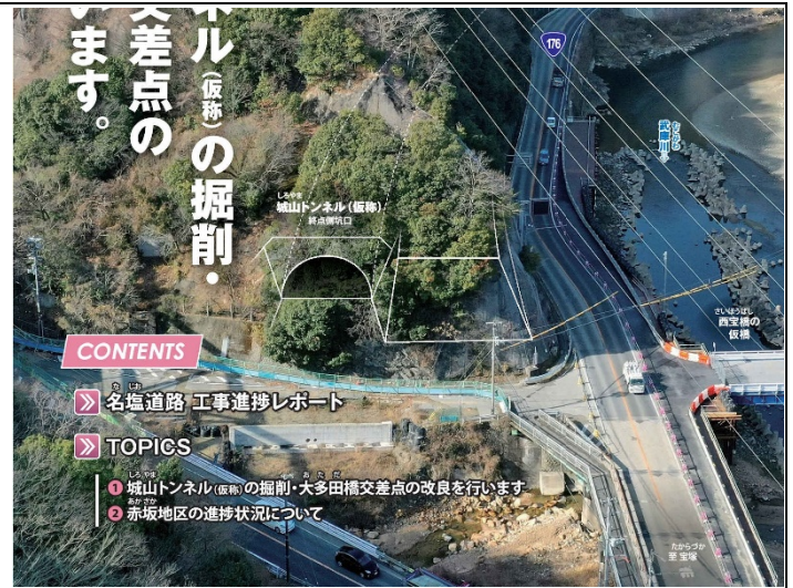
名塩道路工事レポート
