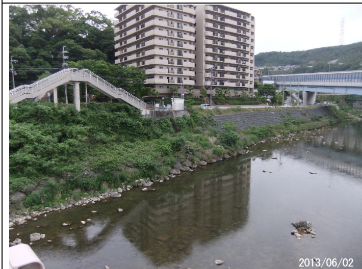
生瀬橋右岸上流 (工事前)
