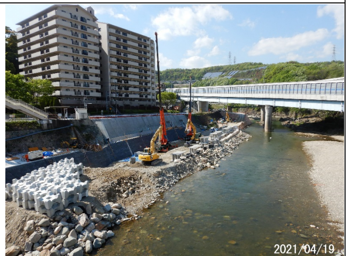
生瀬橋上流左岸の大型ブロック積みつけ工事
