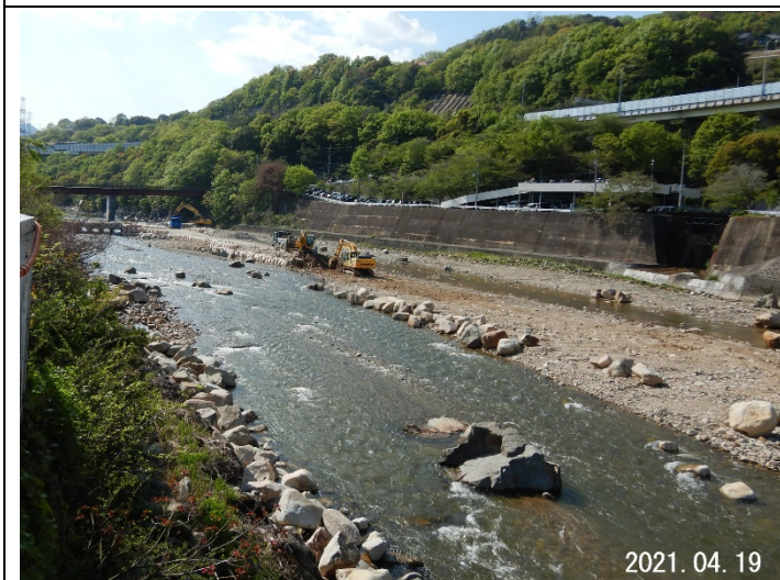
森興橋上流側瀬替え工事
