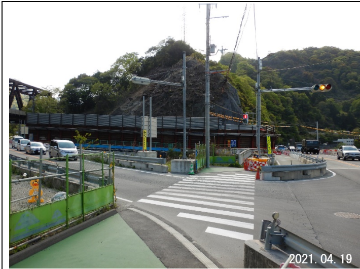
城山トンネル工事現場
