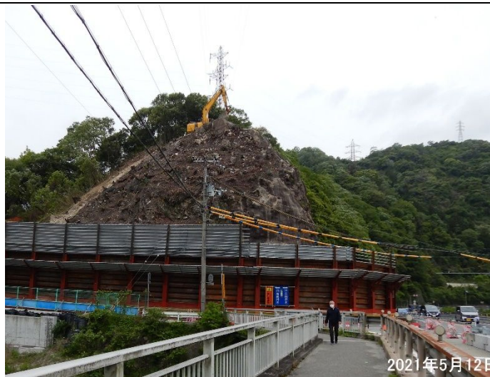
城山トンネル出口工事で山腹掘削工事始まる。
