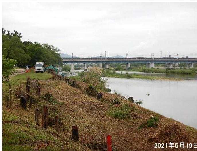
甲武橋～6 堰間の両岸で除伐工事が行われた。
