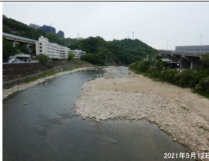
瀬替え工事終了？（森與橋下流方向）
