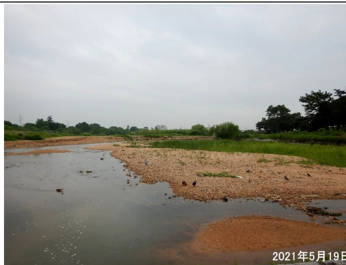
仁川合流点河床掘削後間もないのに陸地化が始まる。
