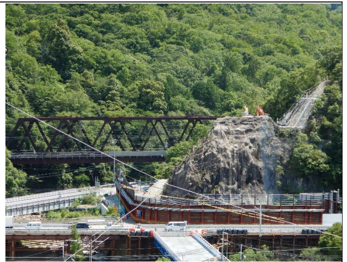
城山トンネル工事現場
