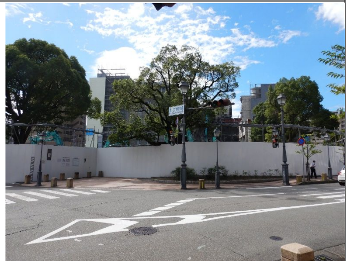
解体進む旧宝塚ホテル 2021年9月21日
