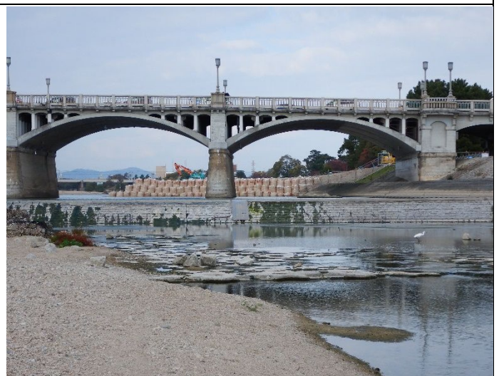
第2堰から見た大島工区
