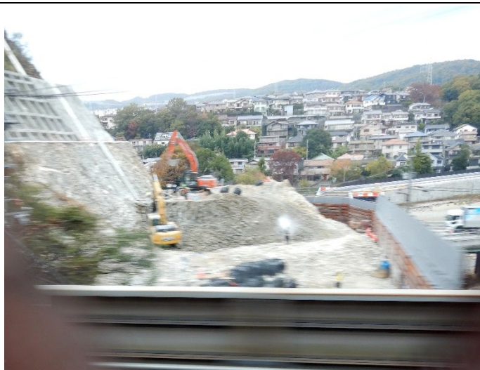
城山トンネル（車窓から）
