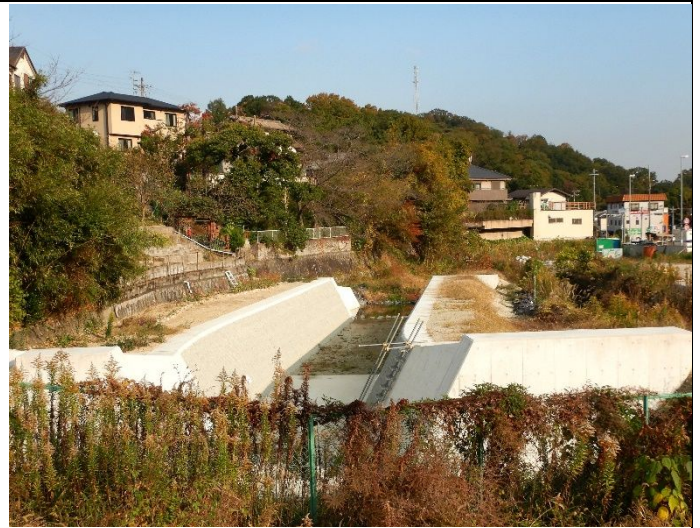
名塩川直線化工事現場
