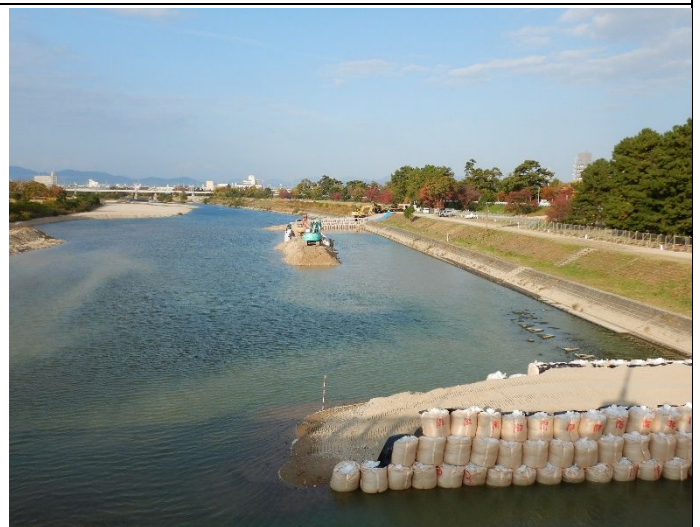
大島工区矢板圧入工事
