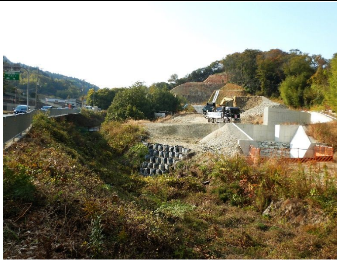
東久保工区名塩かわ付け替え工事現場
