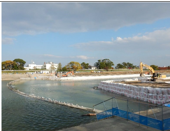
小松工区（1堰直下）低水護岸工事
