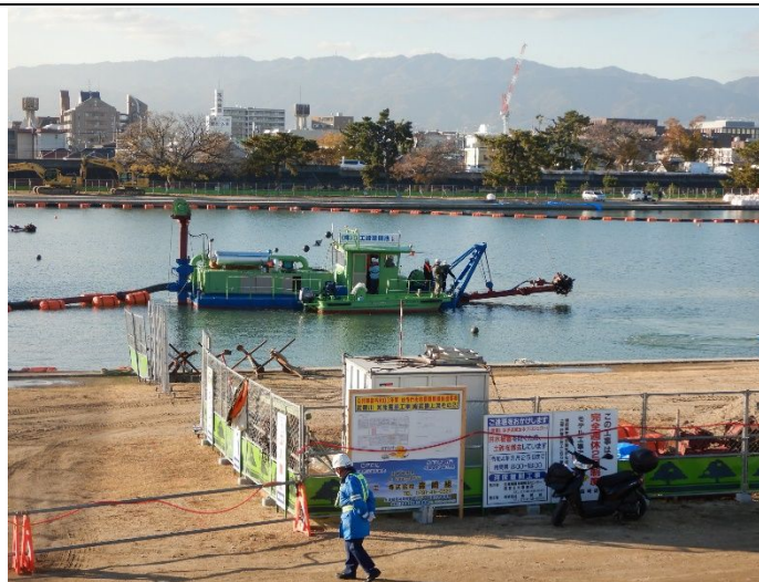
南部橋上流側河床浚渫 2012年12月9日
