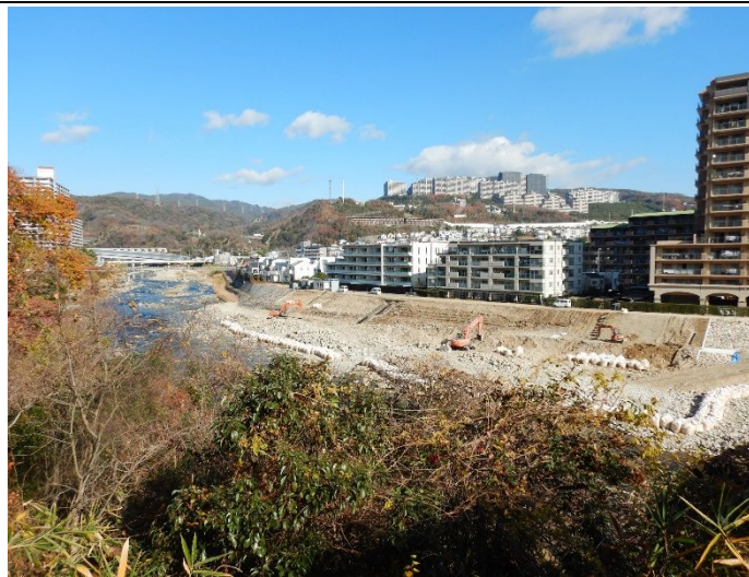
生瀬橋下流河床掘削・堤防強化 2021年12月14日
