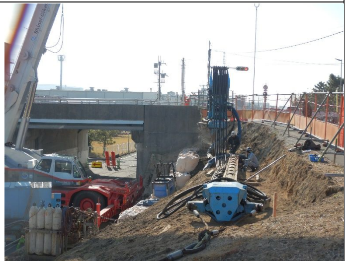
南部橋取り付け道路工事開始 2021年12月16日
