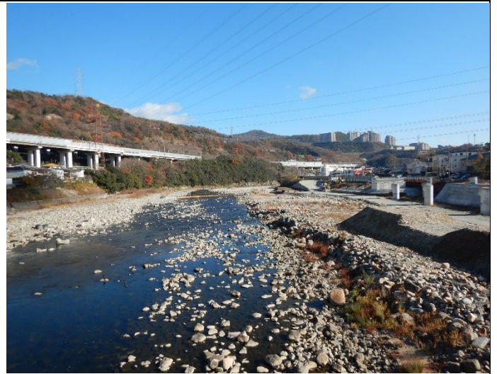
西宝橋下流掘削工事再開 2011年12月14日
