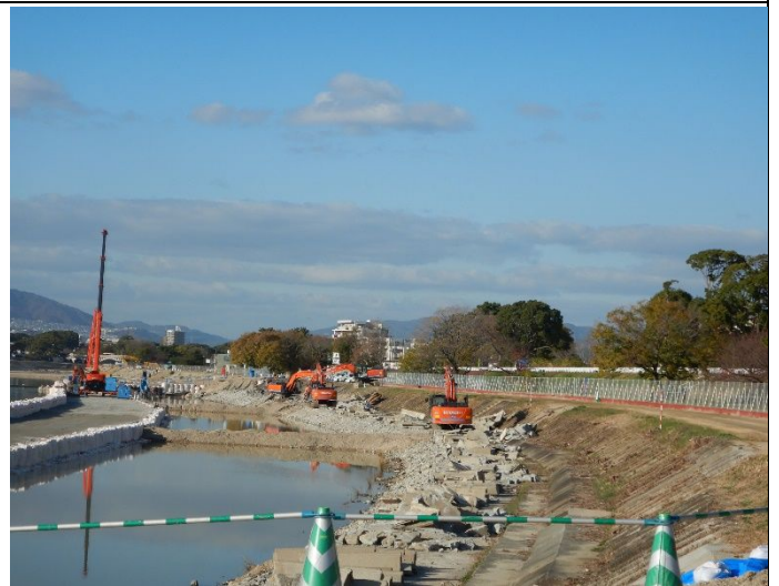
大島工区矢板圧入工事 2021年12月9日
