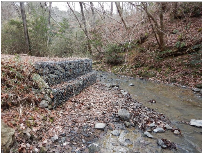
支川まで整備が進む。大池川 2022年1月16日
