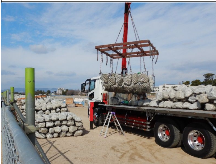
小曾根工区ストーンネット搬入始まる 2022年1月17日
