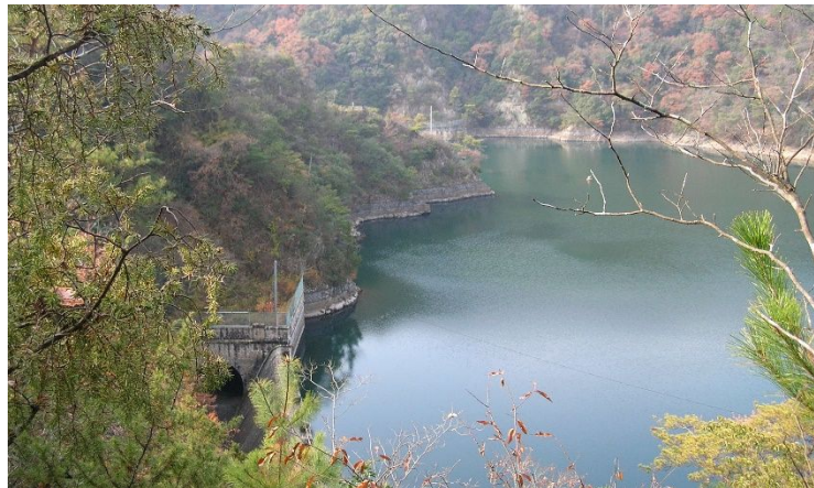
千苺ダム余水吐け
