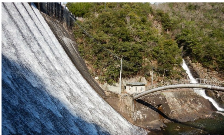
千苺ダム余水放流
