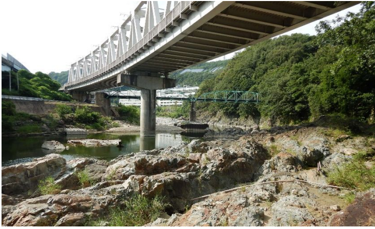
生瀬橋河床から
