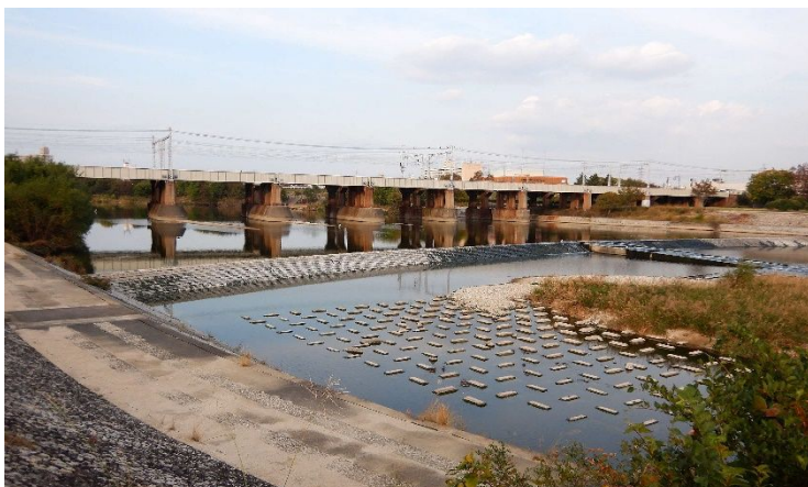
JR 橋梁と第3堰 改修工事でどう変わるのだろうか
