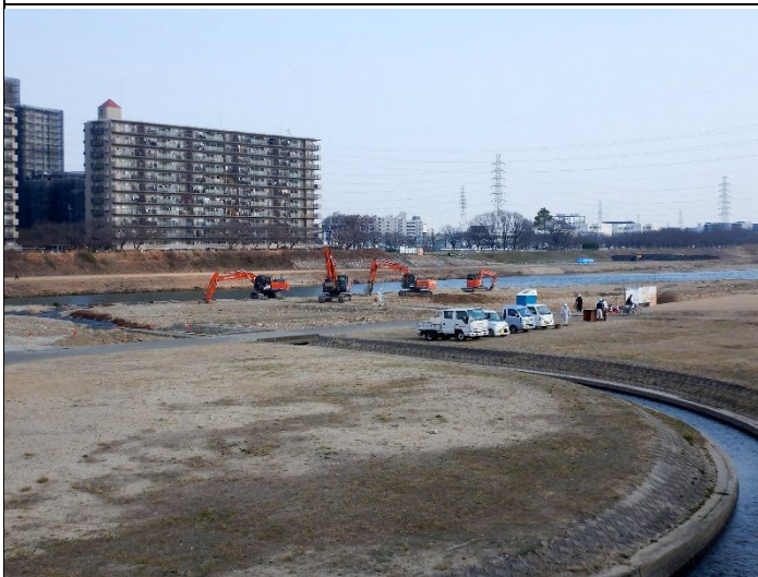
百間樋付河床掘削&高水敷復旧工事 2022年3月12日
