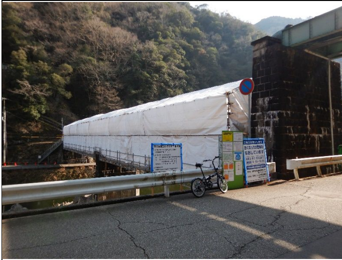
第一水管橋老朽対策工事 2022年3月10日
