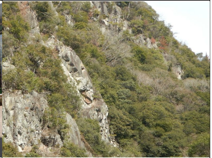
崩落進む長尾山斜面 2022年3月10日
