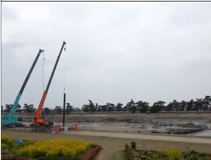
2号堰まで矢板打ち進む 2022年3月17日
