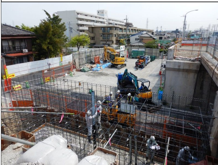
南武橋左岸橋台鉄筋組立 2022年4月17日
