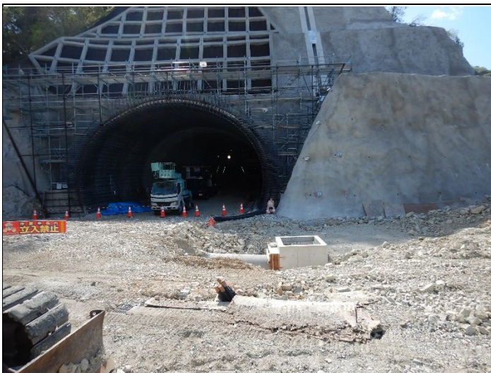
城山トンネル出口工事 2022年4月17日
