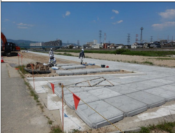
百間樋高水敷ブロック被覆 2022年5月18日
