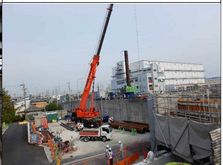
南武橋左岸接続工事中 2022年5月19日
