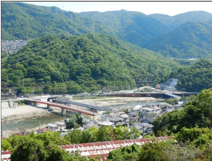
青華接続道から武庫川俯瞰 2022年5月18日
