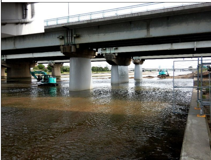
43号線橋脚補強工事終盤 2022年5月19日
