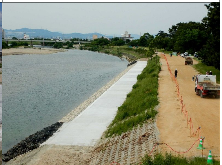
稲葉壮工区工事終盤 2022年5月18日
