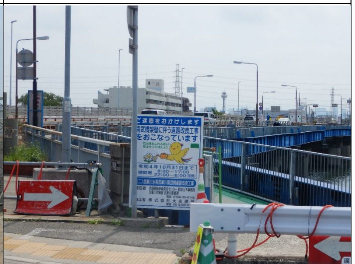
令和4年10月末には付け替え完了。仮設橋撤去？
