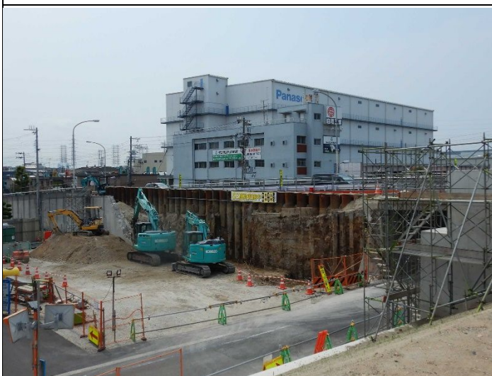
南武橋左岸橋台工事進む
