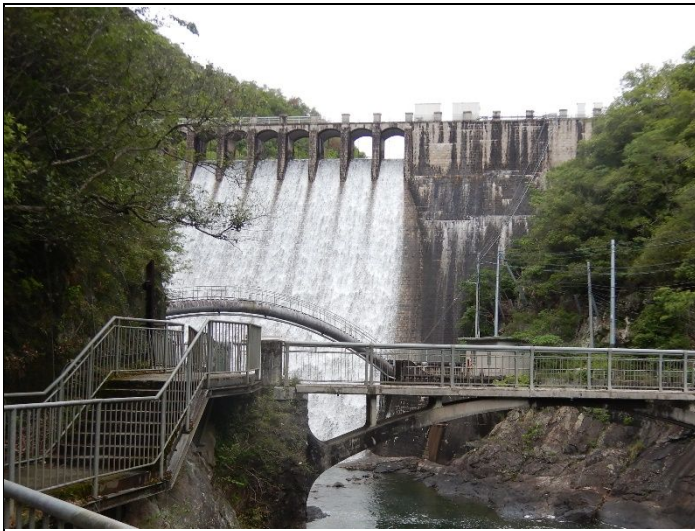
千苅ダム治水活用工事竣工 22年5月28日
