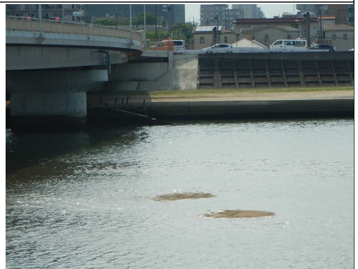
南武橋浚渫区域に土砂堆積は始まった
