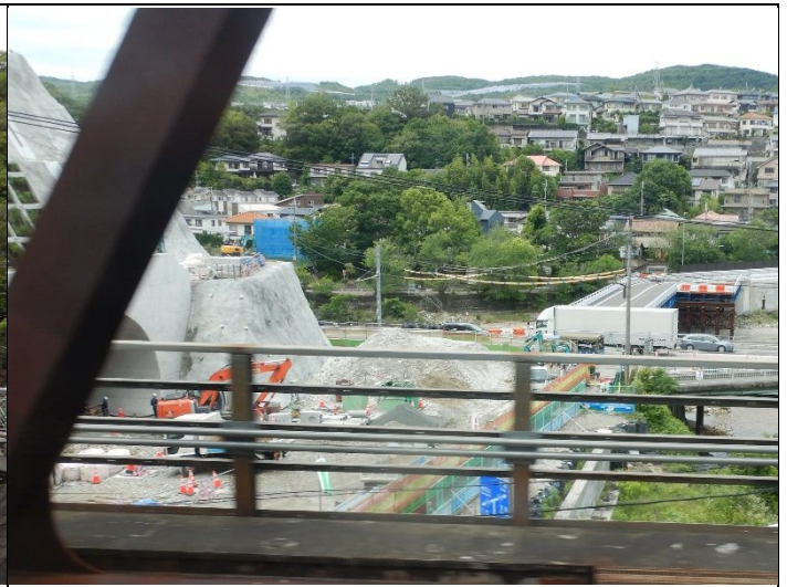
城山トンネル周辺工事進む
