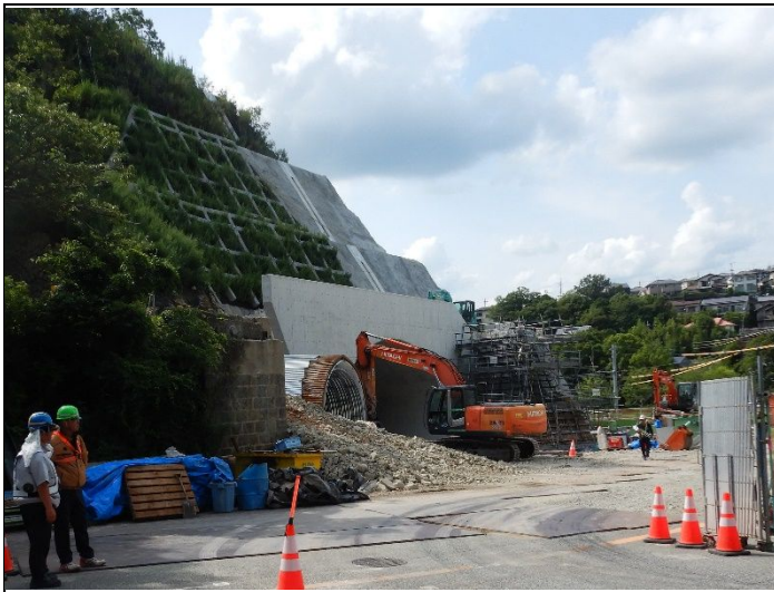
城山トンネル工事 22年7月11日
