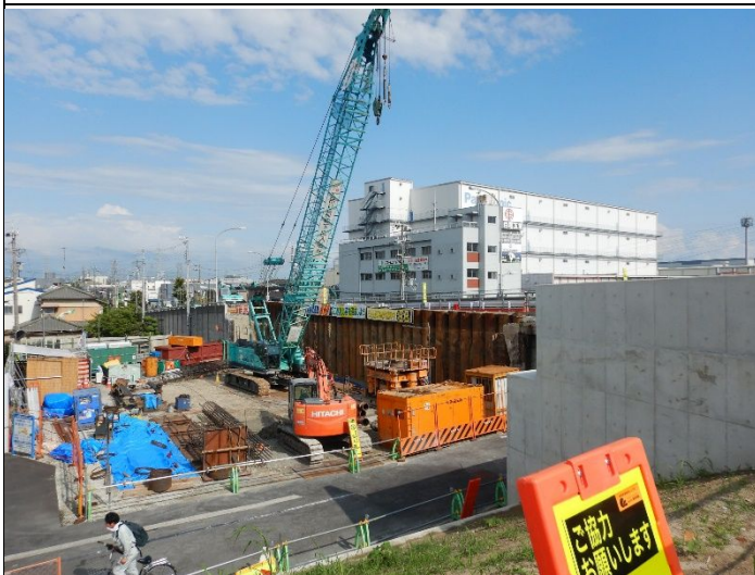
南武橋工事状況 22年7月10日
