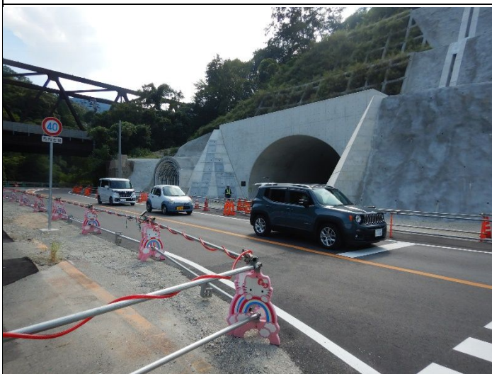
城山トンネル開通、仮設道路切り替えられた
