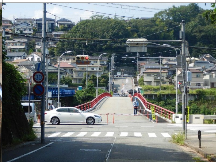
西宝橋通行止めになった。
