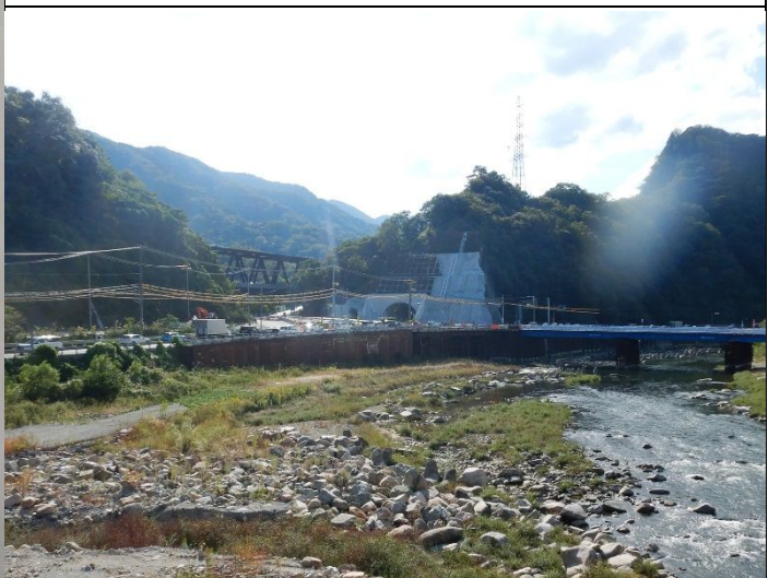
森與橋仮設歩道橋から見た城山トンネル
