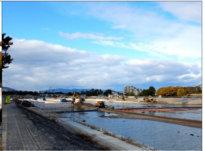
河床掘削が進む 1 号堰下流
