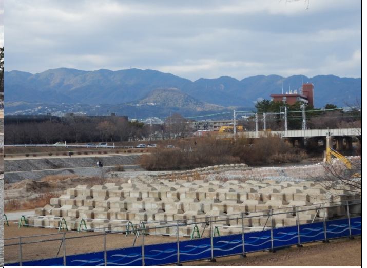
3 号堰改修工事現場の既設護床工回収保存状況
