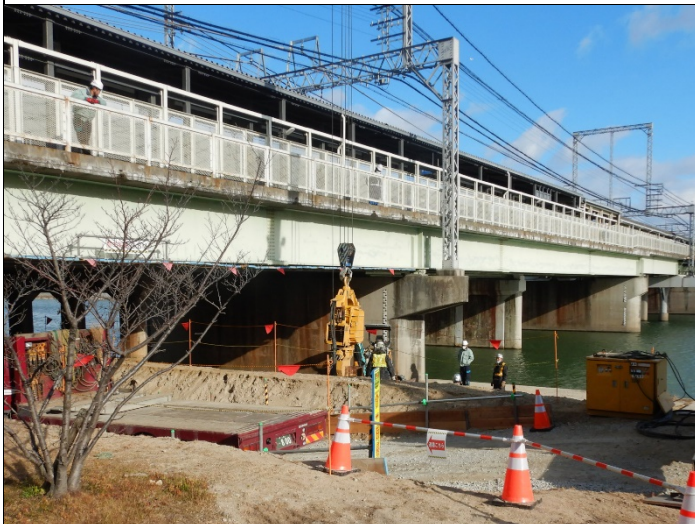
阪神橋梁下で既設矢板抜き工事始まる
