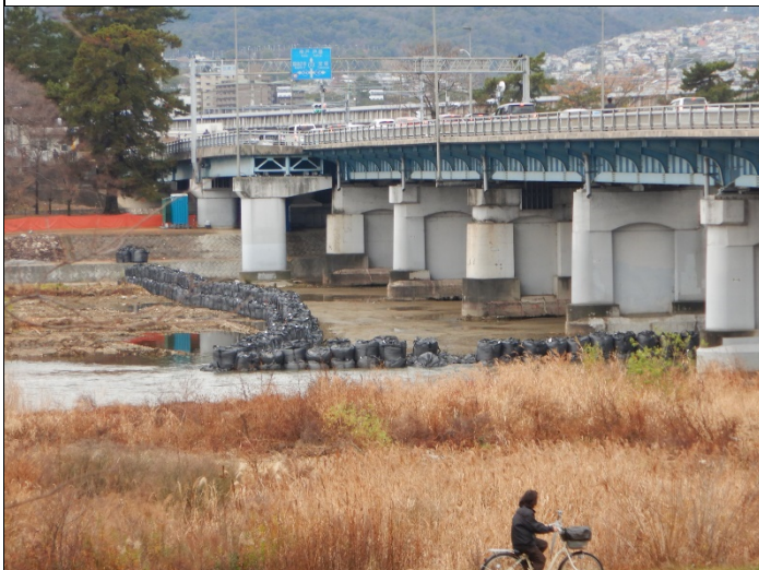
川の中程まで仕切られた甲武橋耐震補強工事現場。1 月 15 日
