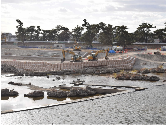
2 堰下流側の河川改修工事現場 2023年 1 月 10 日
