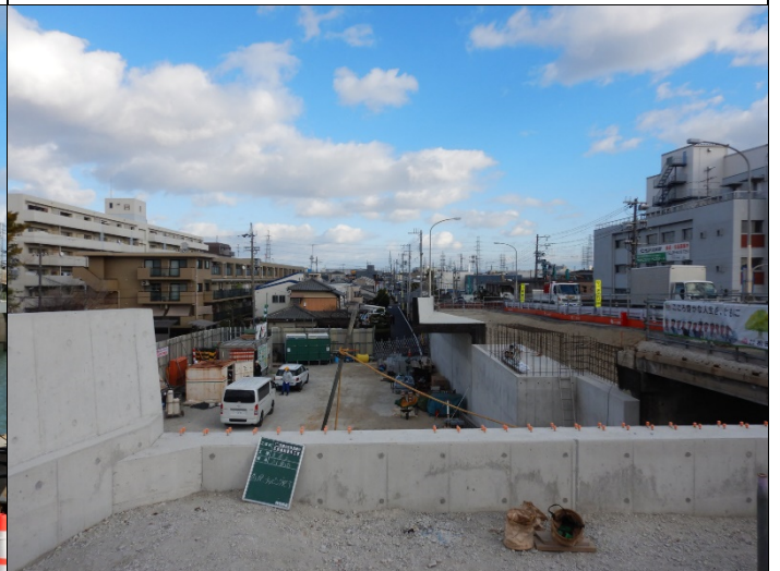
南武橋左岸接続道、架橋直前に迫る
