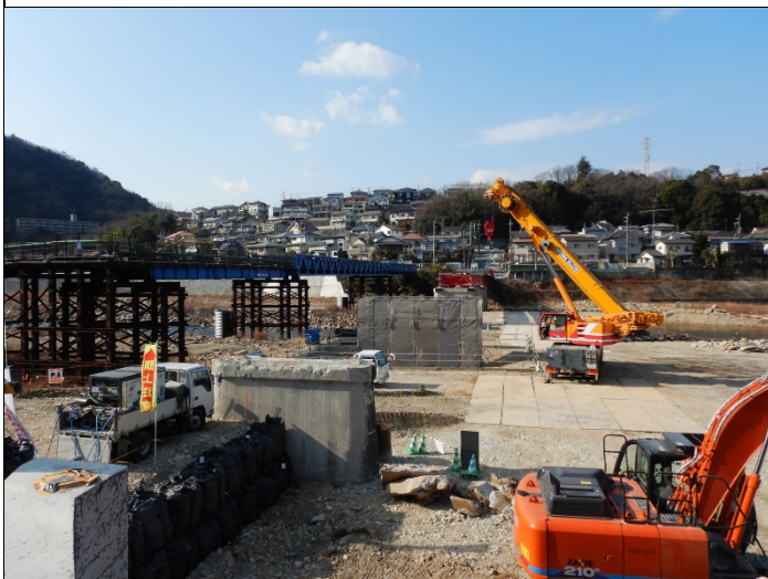
西宝橋撤去工事 3 スパン橋梁撤去が進んだ
