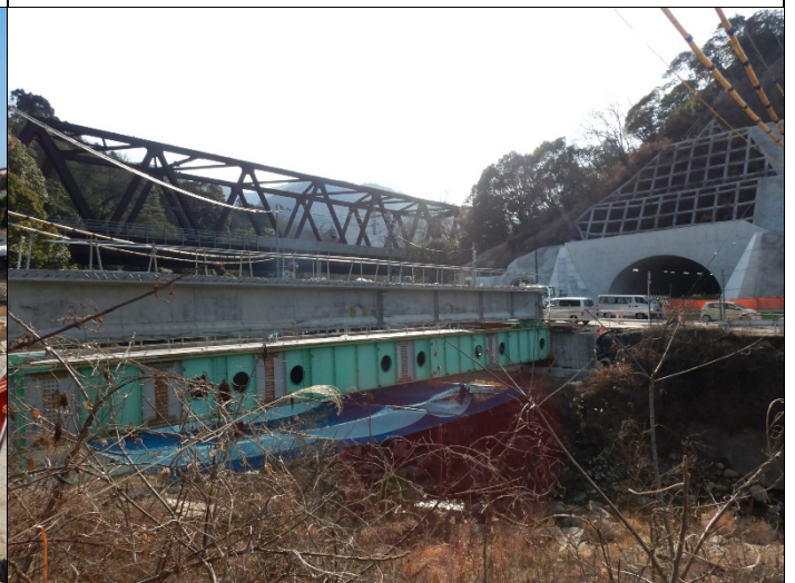
城山トンネル出口橋梁工事の様様
