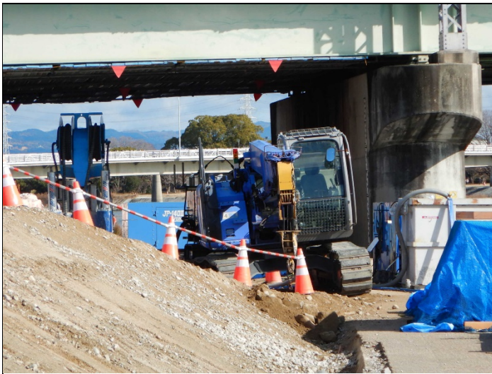
阪神橋梁下矢板打ち工事（矢板の位置まで川幅広がる？）
