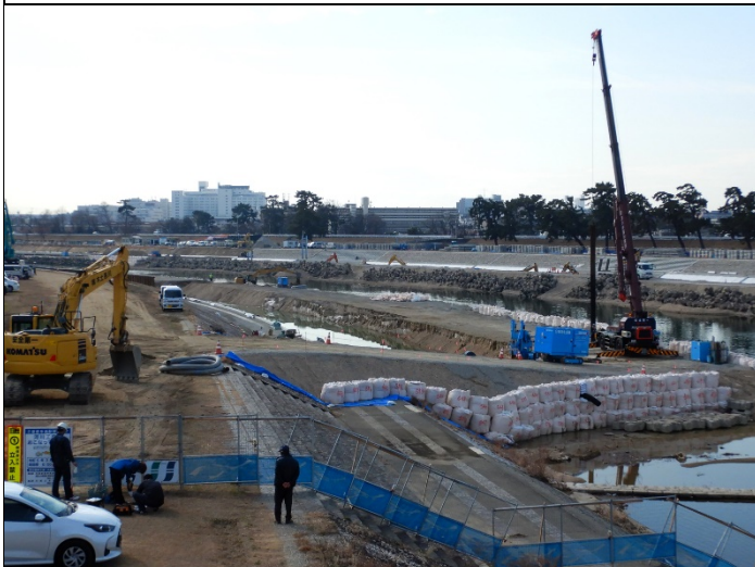
武庫大橋下流側の仕切り堤撤去が始まる
