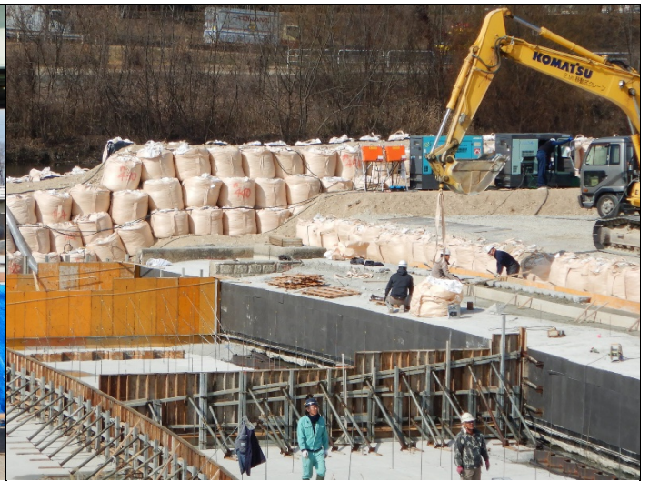
3号堰改修工事現場のコンクリート打設始まる
