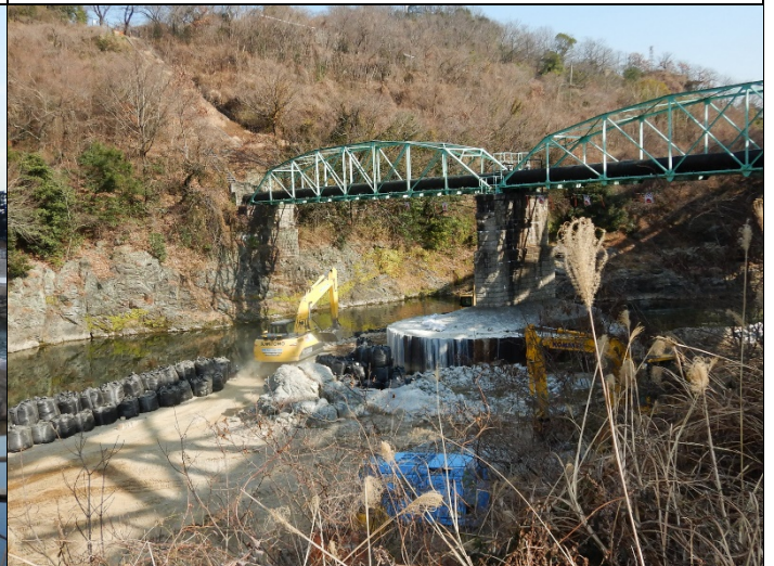
生瀬水管橋橋脚付近で工事始まる。
