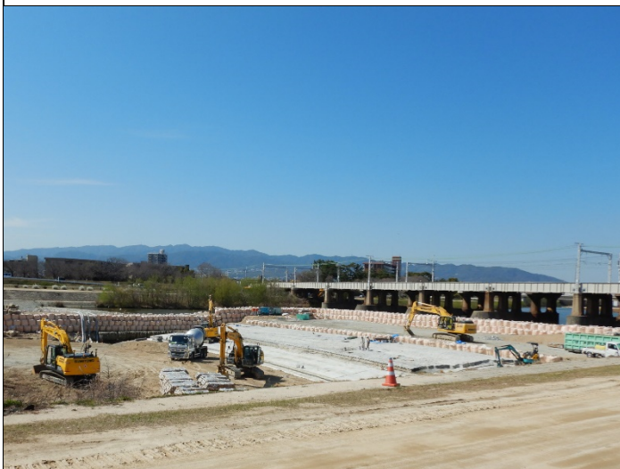
順調に工事が進む3号堰
