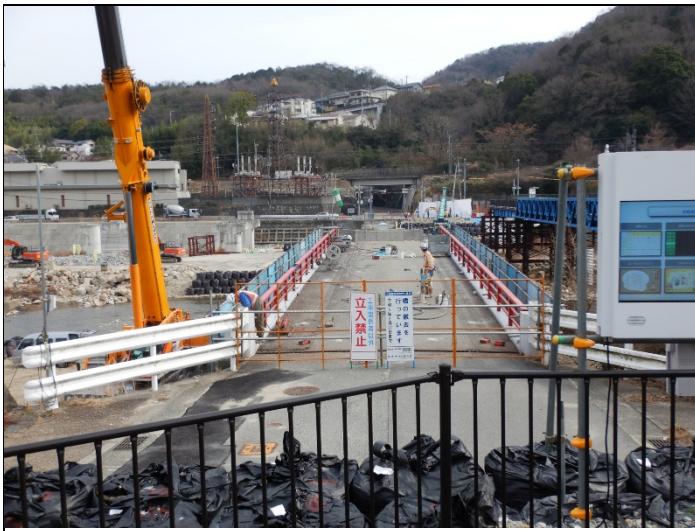
撤去工事中西宝橋（青葉台側から）
