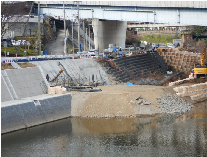
生瀬橋上流右岸の上流大型ブロック護岸工事
