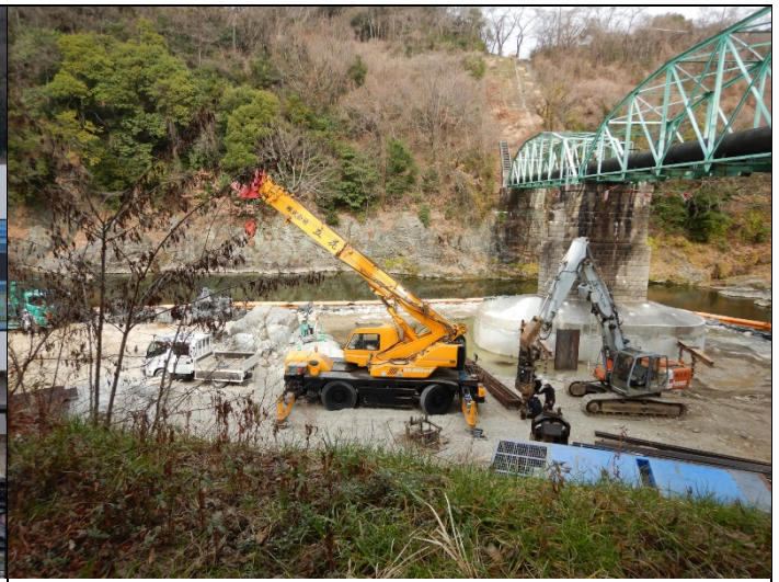
橋脚補修工事中の生瀬水管橋
