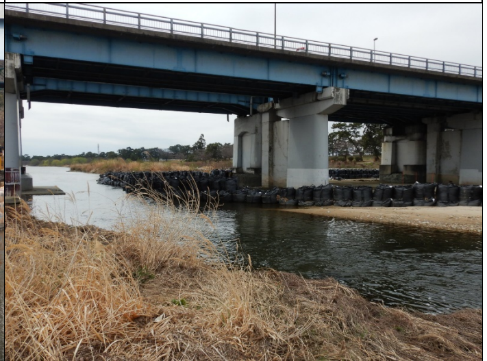
右岸側橋脚耐震補強工事中の甲武橋。
