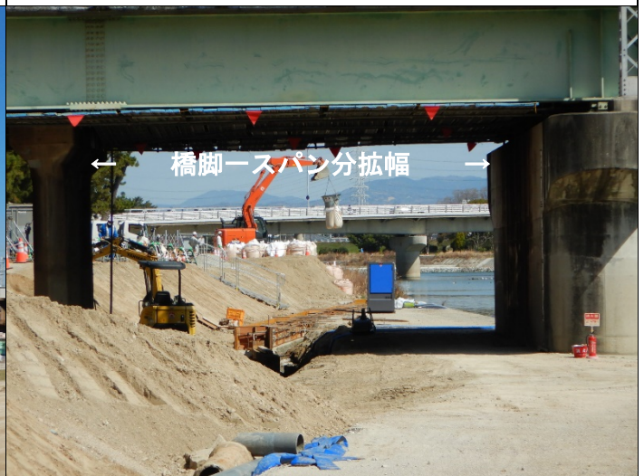
阪神橋梁した矢板打ち終わる
