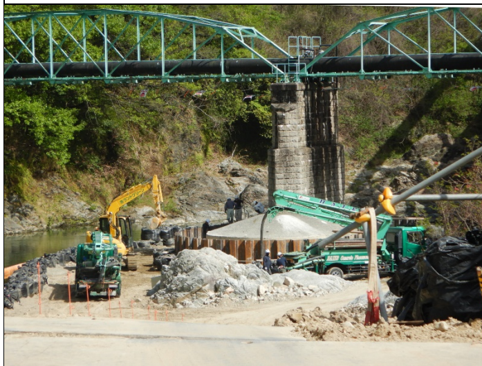
生瀬水管橋橋脚根巻復旧工事の様様
