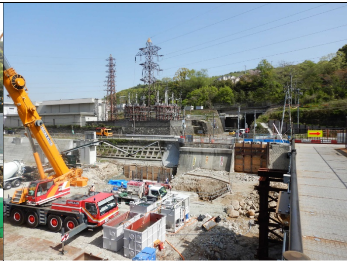
西宝橋橋梁撤去された
