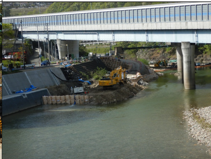
生瀬橋上流右岸高水護岸大型ブロック工事。
