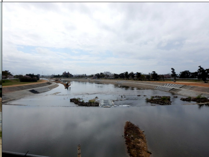
武庫大橋下流側。スッキリしたけど風景の単調さは否めない
