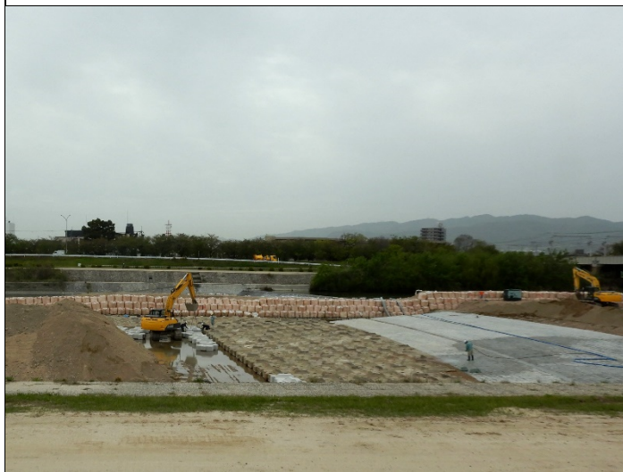
3号床止め工改修。古いブロックを活かして施工されている。
