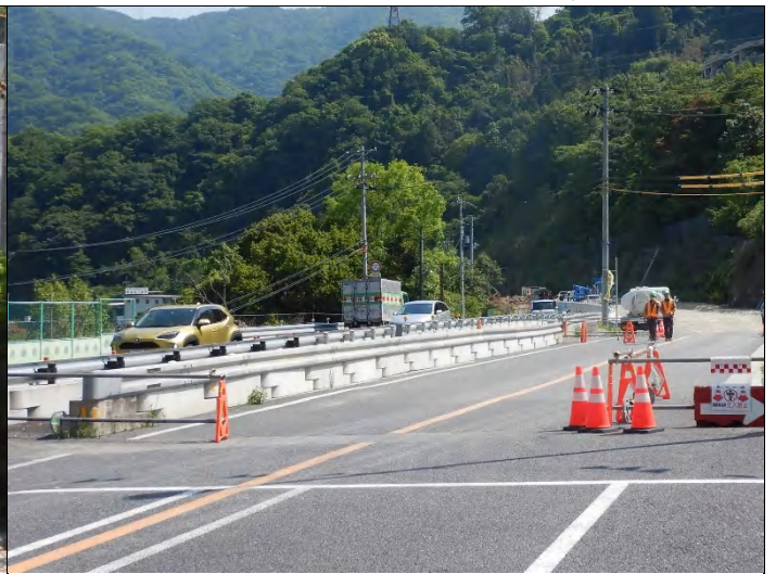
城山トンネル木之元側取っ付き道路整備進む
