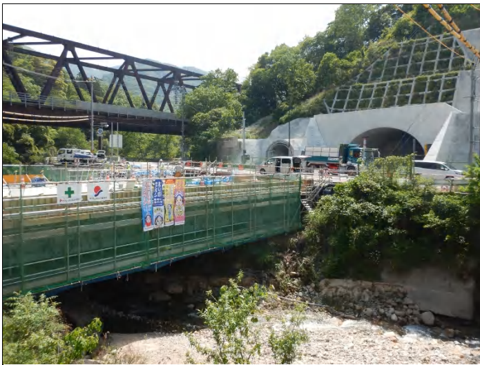
大多田橋梁？橋梁下部空間狭くなった様に難じる
