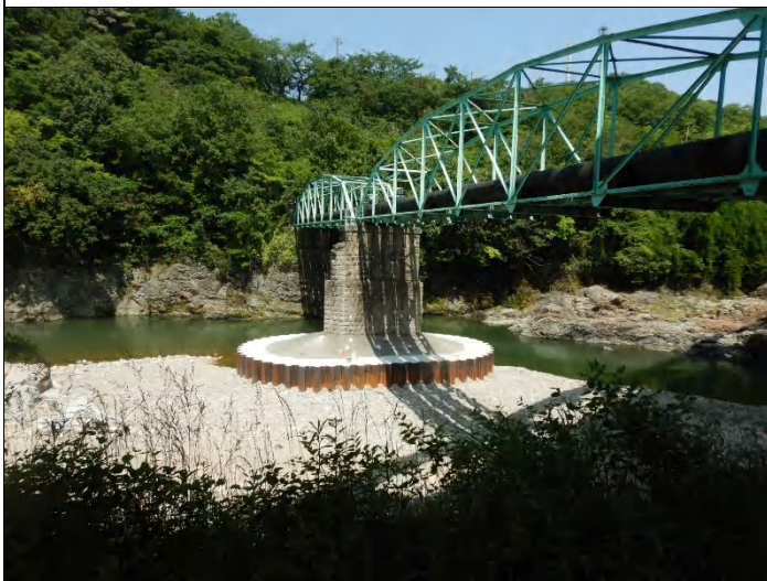
生瀬水管橋橋脚根巻復旧工事終わる
