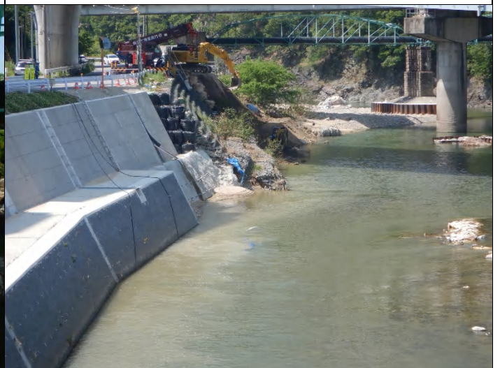
生瀬橋上流右岸高水護岸大型ブロック工事終了。
